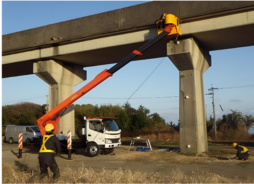
Figure 29 : Mesure vibratoire d'une pile de pont au Japon destinée à quantifier la perte de rigidité des fondations liée au phénomène d'affouillement [11] (Source : Japan Railway Technical Research Institute (RTRI))
