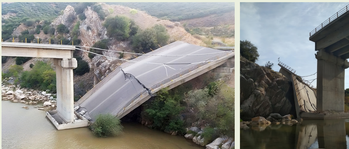
Figure 25 : Effondrement d'une des travées du pont de Komsatos en Grèce en 2017 après un échappement d'appui causé par la rotation de la base d'une pile sous l'effet de l'affouillement de sa fondation (Source : Egnatia Motorway)
