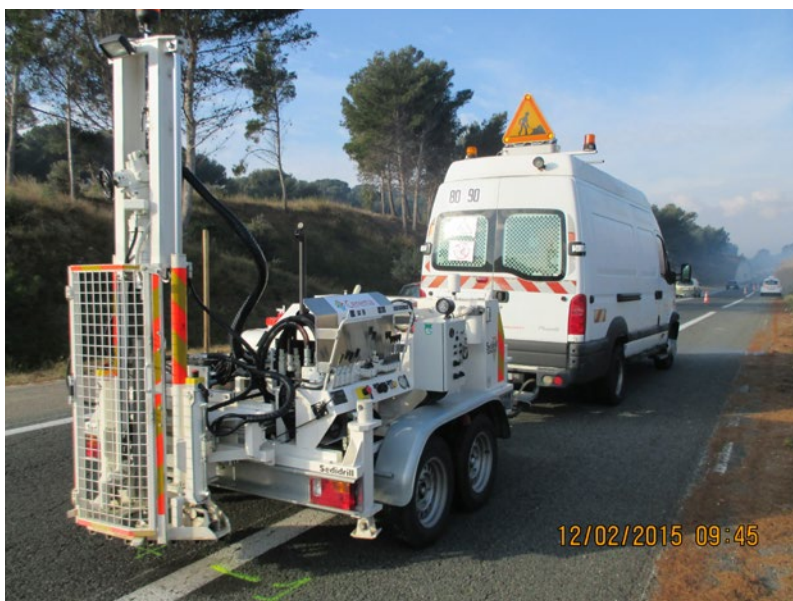
Figure 7 - Carottage de chaussées dans le cadre d'un diagnostic (source: Cerema)
