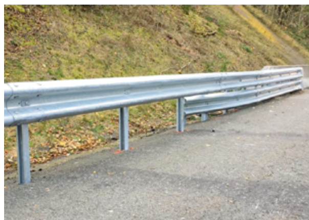
Photos 14 et 15 : Exemples de traitement d'une extrémité de file d'ouvrages coulés en place par raccordement NF 058 à une barrière de sécurité CE (Source : Cerema)
