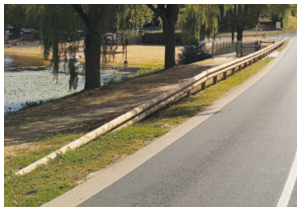
Photos 11 et 12 : Extrémités déportées, abaissées et enterrées dans le sol – Origine de file (à gauche) et fin de file (à droite) (Source : Cerema)
