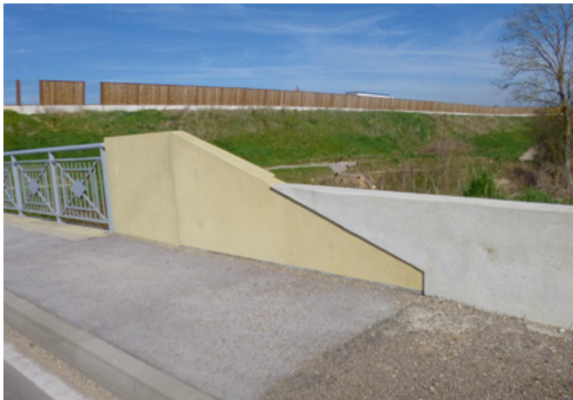
Photo 22 : Transition d'un ouvrage coulé en place sur ouvrage existant (Source : Cerema)
