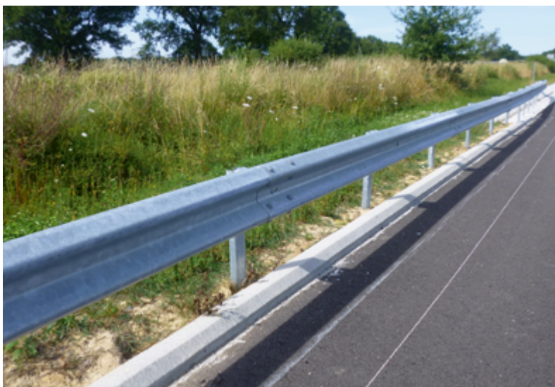
Photo 2 : Barrière de sécurité implantée derrière un bourrelet (Source : Cerema)
