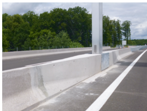
Photos 5 et 6 : Traitement d'un obstacle ponctuel en TPC où le V_n n'a pas pu être respecté : PPHM posé sur massif hors-sol et raccordé sur DBA (à gauche) – Interruption du séparateur avec capot droit (à droite) (Source : Cerema)
