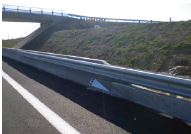
Photos 14 et 15 : Exemples de traitement d'une extrémité de file d'ouvrages coulés en place par raccordement NF 058 à une barrière de sécurité CE (Source : Cerema)
