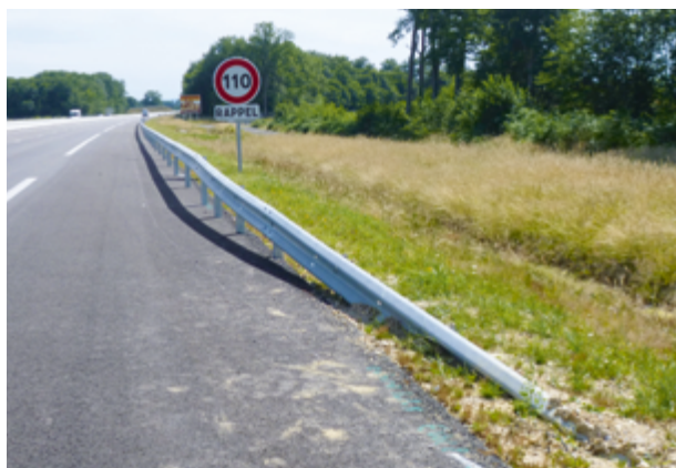
Photos 11 et 12 : Extrémités déportées, abaissées et enterrées dans le sol – Origine de file (à gauche) et fin de file (à droite) (Source : Cerema)
