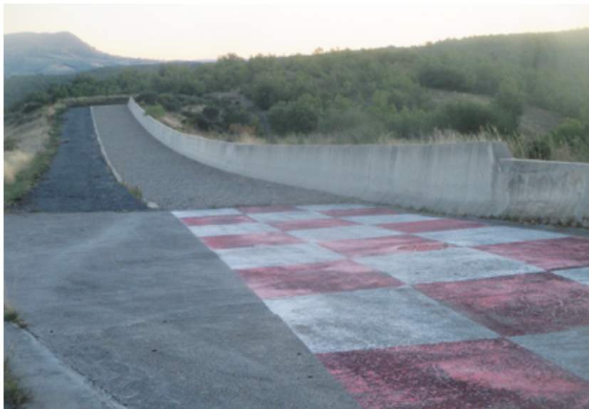
Photo 23 : Lit d'arrêt (Source : Cerema)
