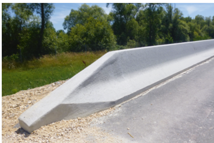
Photo 16 : Abaissement d'une GBA sur 1,65 m en fin de file (Source : Cerema)
