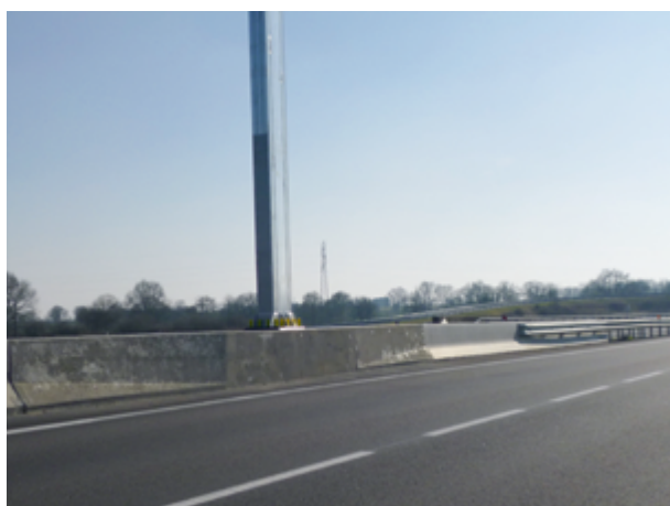
Photos 5 et 6 : Traitement d'un obstacle ponctuel en TPC où le V_n n'a pas pu être respecté : PPHM posé sur massif hors-sol et raccordé sur DBA (à gauche) – Interruption du séparateur avec capot droit (à droite) (Source : Cerema)
