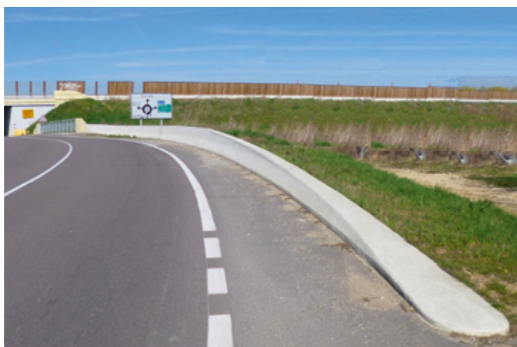
Photo 17 : Abaissement d'une DBA sur 20 m en origine de file (Source : Cerema)
