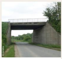
Ouvrage monolithique composé d'une dalle en béton armé encastrée dans deux piédroits euxmêmes en béton armé dans la plupart des cas. À la différence du portique, le cadre comporte un radier à sa base, généralement non visible. Un cadre ou un portique est assorti de murs de part et d'autre de la voie.
