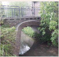
Pont composé d'une seule arche ou d'arches multiples, constitué la plupart du temps de maçonnerie (pierres, briques) jointoyée ou dans certains cas de béton
