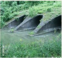
Ouvrage de forme cylindrique ou ovoïde servant généralement au passage d'un cours d'eau ou de chemins agricoles, composé de tôles assemblées par boulonnage (buse métallique) ou de béton.
