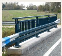
Les équipements (ou superstructures) sont des éléments posés ou fixés à la structure, qui participent à la fonction d'usage d'un ouvrage (sécurité, confort, esthétique). Il s'agit par exemple des dispositifs de collecte et d'évacuation des eaux (caniveaux, gargouilles, cunettes), des garde-corps, des joints de chaussée, des corniches...
