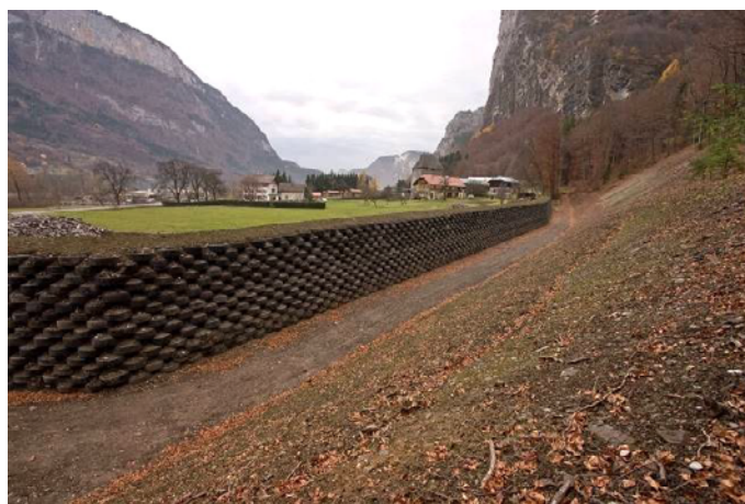
Merlon en remblai à double parement raidi - Magland (74) (Crédit photo : Arias Montagne)
