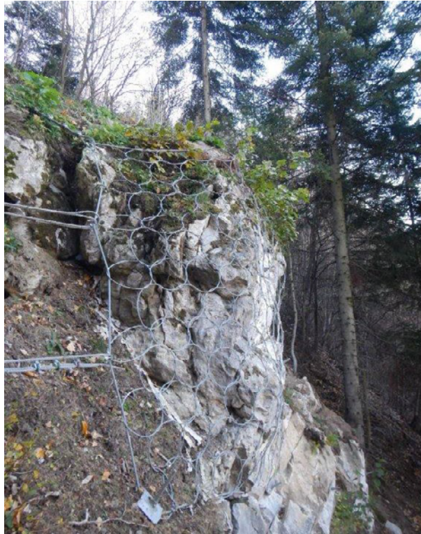
Filet à anneaux 6 contacts - RD 81 - Le Bochet (Crédit photo : CD73)
