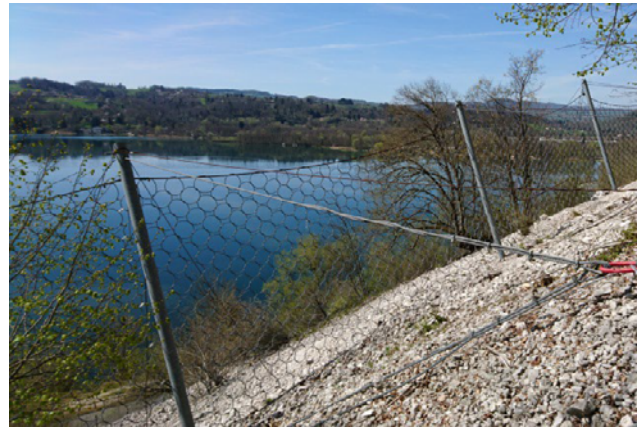
Illustration 2 : Écran 100kJ - Lac d'Aiguebelette (Crédit photo : CD73)
