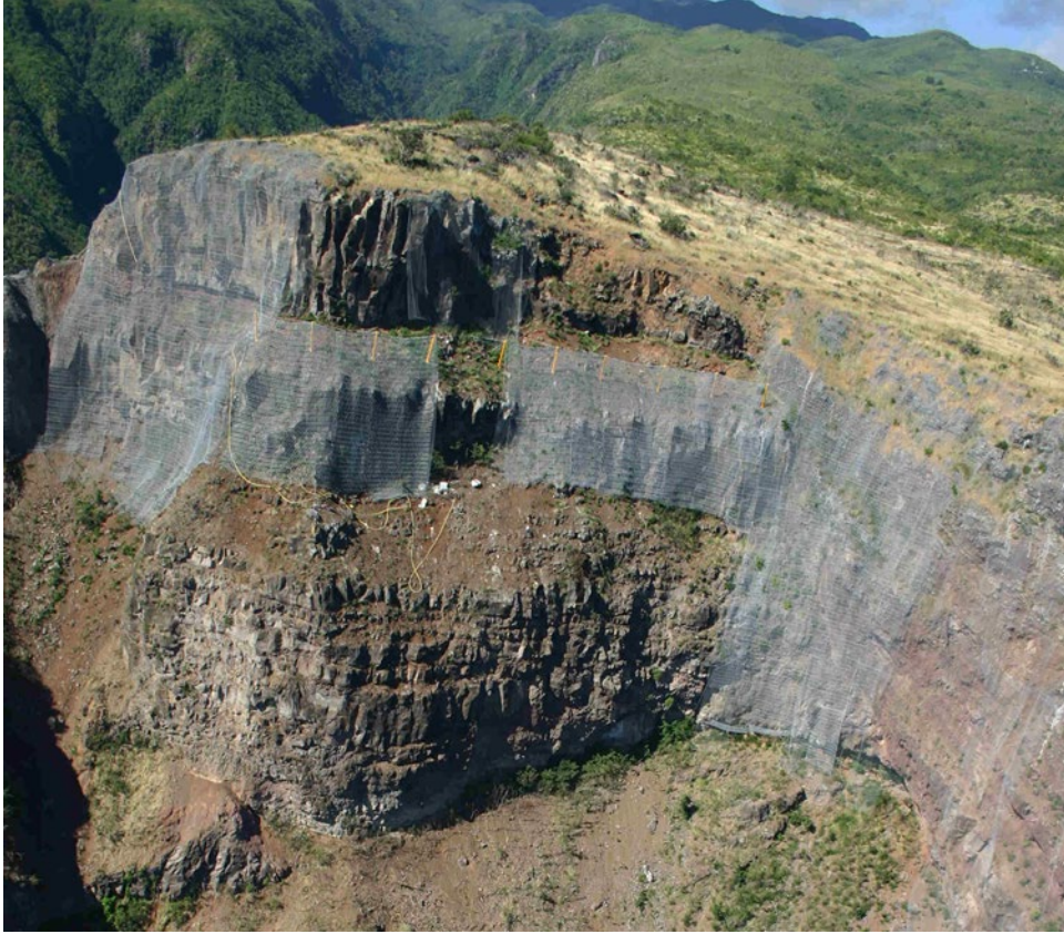
Ouvrages déflecteurs pendus et avaloirs en cours de pose - RN1 La Réunion (Crédit photo : Cerema)
