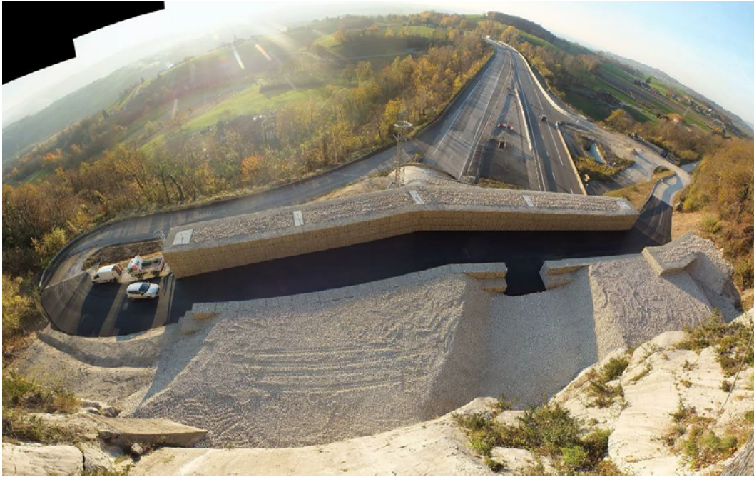
Merlon mixte Gabions/Remblai - Tête Ouest du tunnel de Dullin - A43 (73) (Crédit photo : Arias Montagne)
