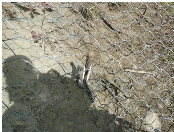
Barre en place - la canule et la gaine géotextile (chaussette) sont visibles (Crédit photo : Cerema)
