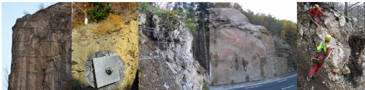
Figure 4 : Parades actives : Emmaillotage câble (©Parn) ; Ancrages(©Parn) ; Filet plaqué (© CD73) ; Béton projeté (Cerema) ; Purge (© Cerema)
