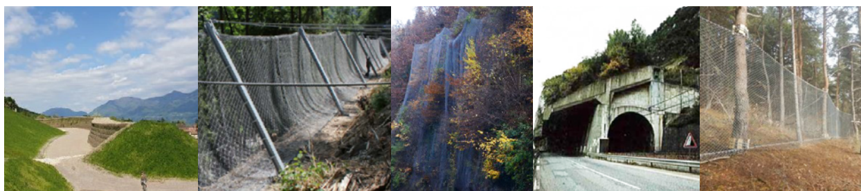
Figure 5 : Parades passives : Merlon pare-blocs (© PARN) ; Ecrans de filets pare-blocs (© CD38) ; Déflecteurs (©PARN) ; Galerie et casquette pare-blocs (©PARN) ; Ecrans forestiers (©ARIAS Montagne)
