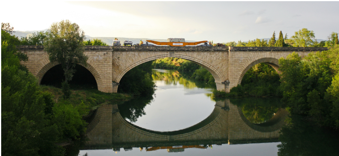
Figure 21 : Exemple de surcharge d'exploitation sur un ouvrage en maçonnerie (convoi de 260 T)
