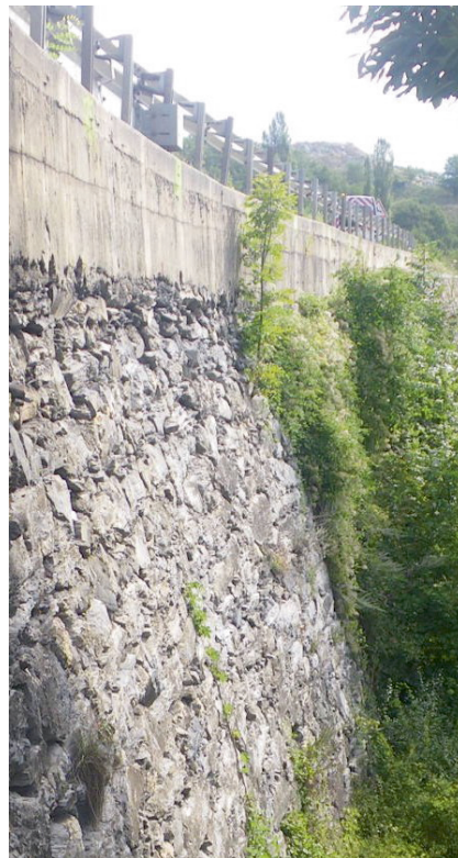
Figure 17 : Exemple de mur portant un dispositif de sécurité
