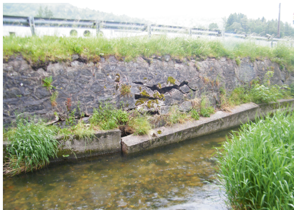
Figure 4 : Exemples de rupture de mur en maçonnerie
