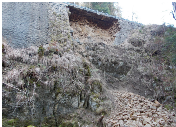
Figure 4 : Exemples de rupture de mur en maçonnerie
