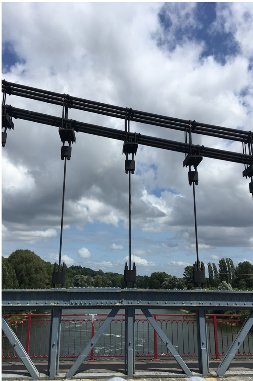
Illustration 3 : Suspentes et leurs attaches
