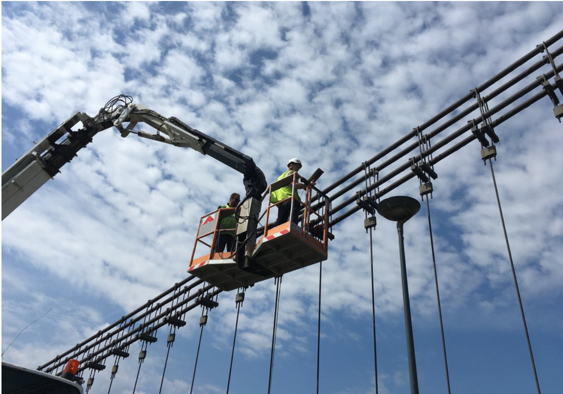
Illustration 6 : Auscultation électromagnétique des câbles
