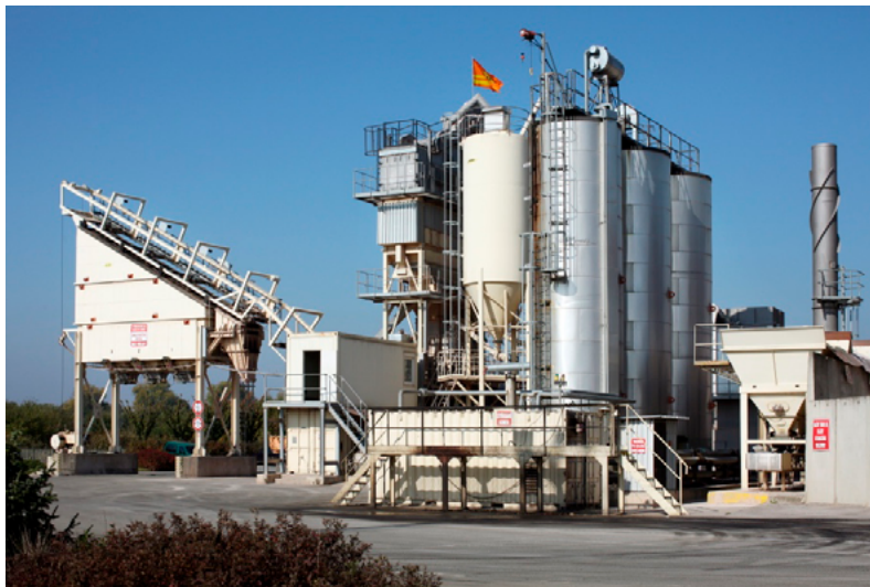
Figure 10 : Poste d'enrobage discontinu (Source : © Colas - Martin Kollar)
