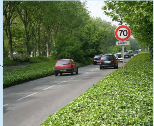
Requalification du périphérique nord en artère urbaine
