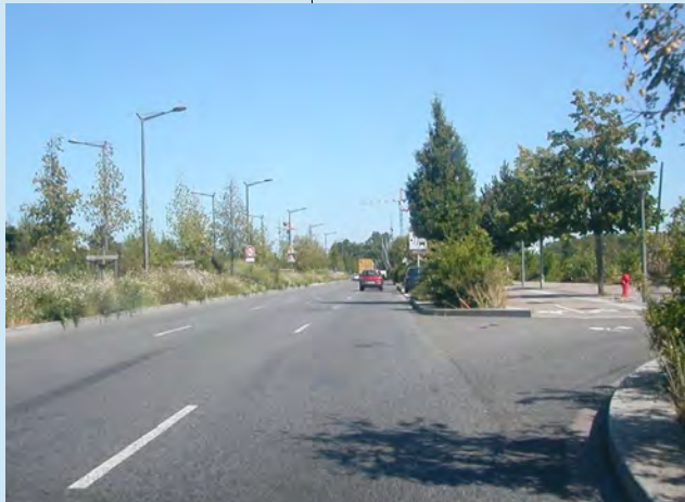
Requalification de l'arrivée de la D363 en boulevard
