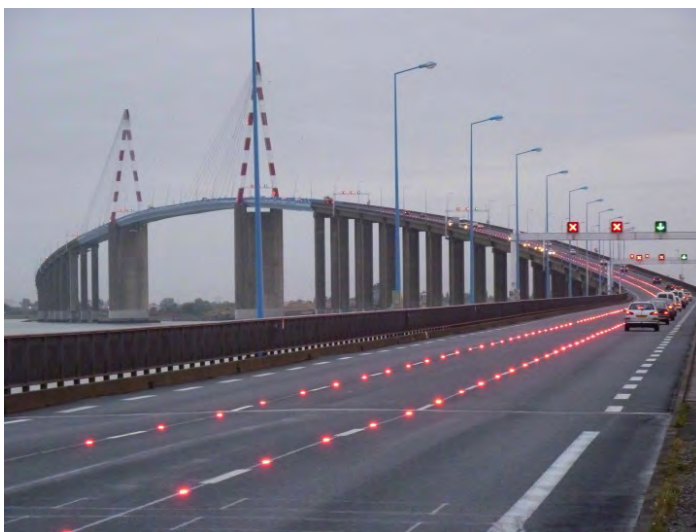
Pont de Saint-Nazaire : voie centrale alternée ouverte selon la demande pendulaire de trafic. Initialement à deux voies, la traversée du pont occasionnait des bouchons le matin dans un sens et le soir dans l'autre. L'ajout de cette troisième voie a permis d'améliorer nettement les conditions de circulation.
