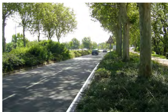
Boulevard de la Doua à Lyon (AU70)
