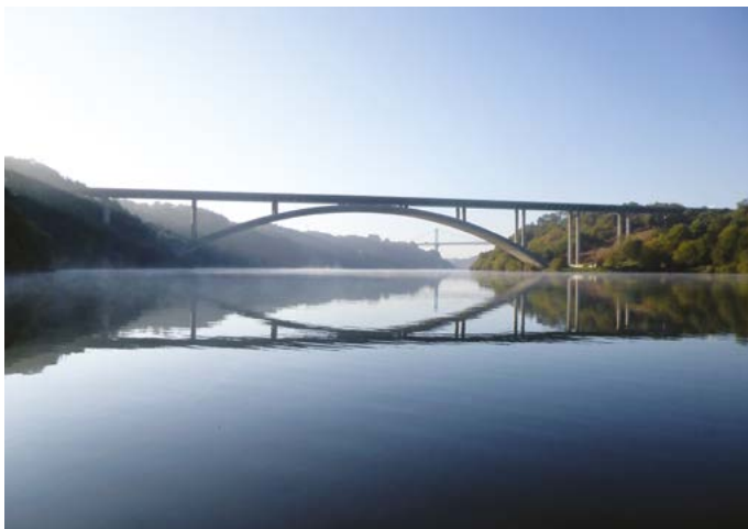
Photo 1 : Pont en Arc (Source : © Cerema)
