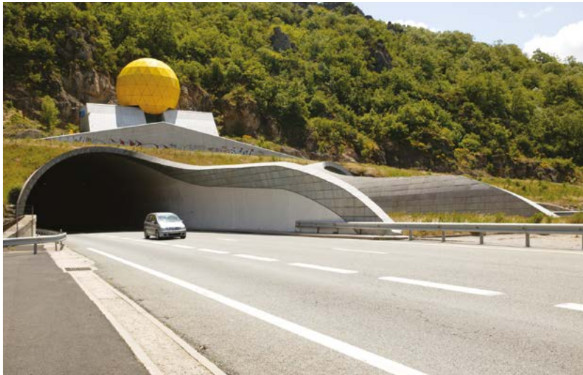
Photo 7 : Tunnel du Pas de l'Escalette - A 75 (Source : © Cerema)
