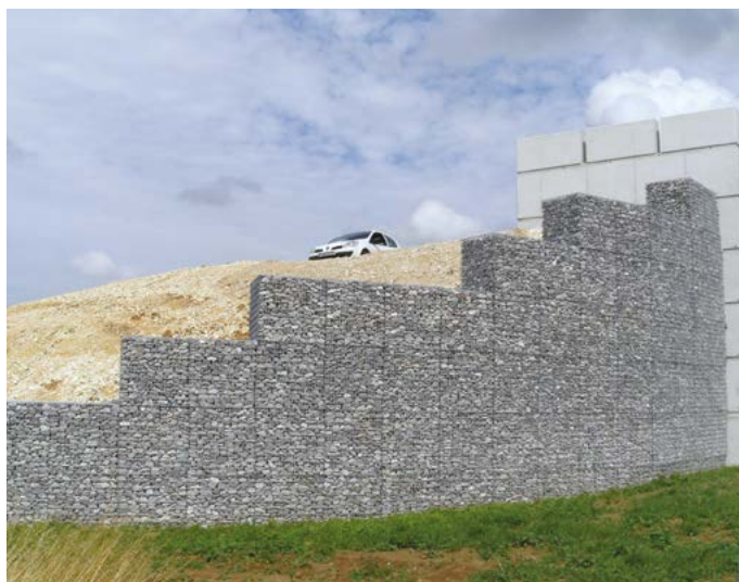
Photo 6 : Mur de soutènement en gabions (Source : © Cerema)
