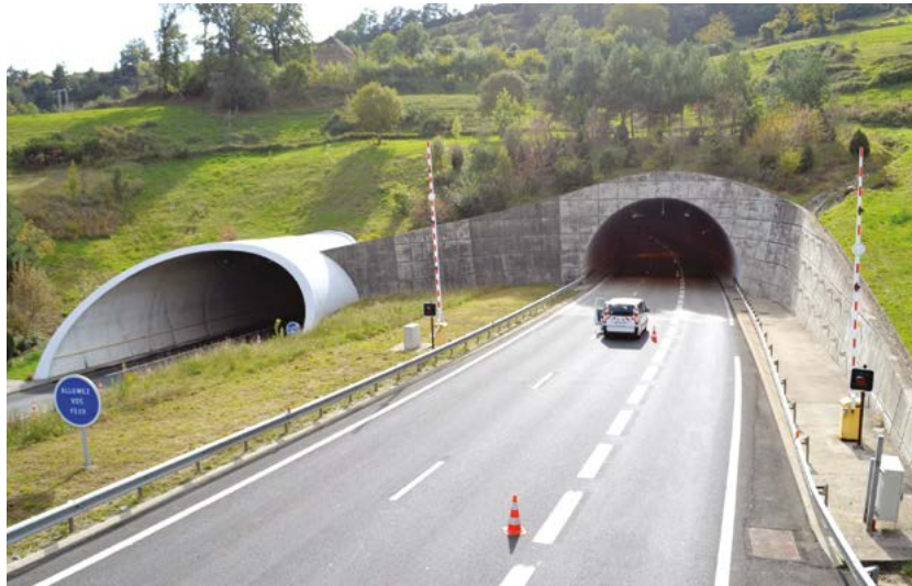
Photo 8 : Tunnel de Montjézieu - A 75 (Source : © CETU)
