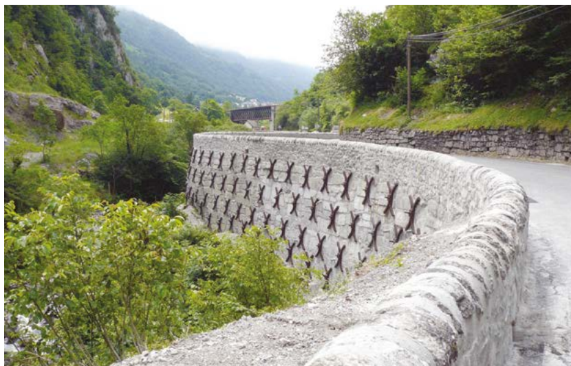
Photo 9 : Mur de soutènement - RN 134 (Source : © DIRA)
