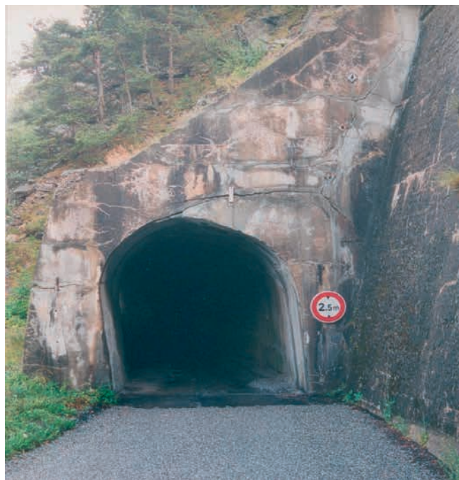
Figure 2 : tête déformée par le glissement du versant
