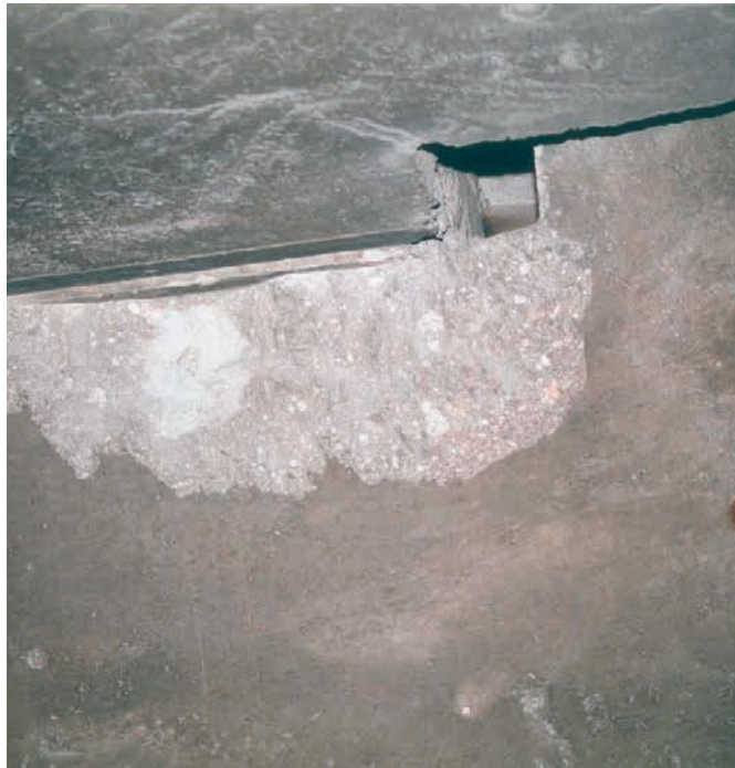
Figure 1 : écaille tombée sous une engravure
