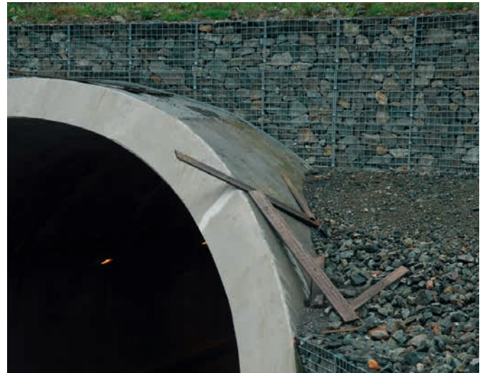
Figure 1a et 1b : végétation dense pouvant créer des instabilités aux têtes – Objets pouvant tomber sur la chaussée
