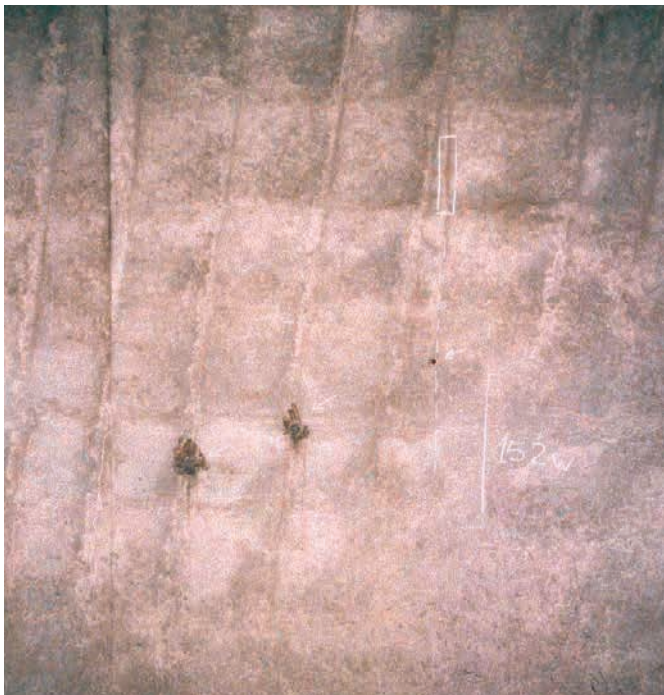
Figure 3 : spectre des armatures en piédroit d'anneau
