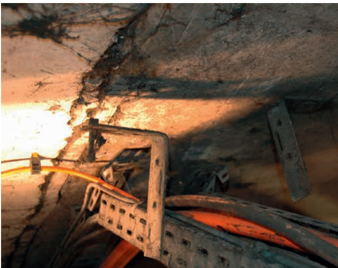
Figure 2a et 2b : fixations de suspente de chemin de câble ou de caméra sectionnées partiellement ou totalement
