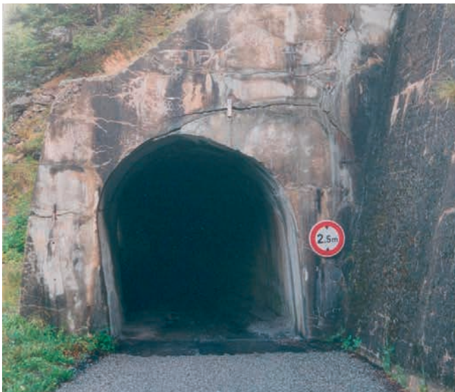
Figure 1 : tête déformée par le glissement du versant
