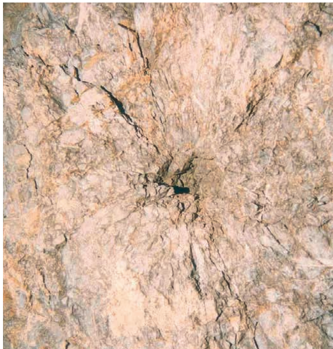
Figure 1 : calcaire dérocté au début du XIXème siècle [on distingue les fractures rayonnantes autour du forage de tir ; l'ensemble de la roche est désorganisé et instable]
