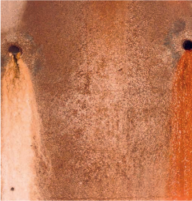
Figure 3 : concrétions claires de calcite (à gauche) ; dépôt de gel rouge, riche en oxyde de fer (à droite)
