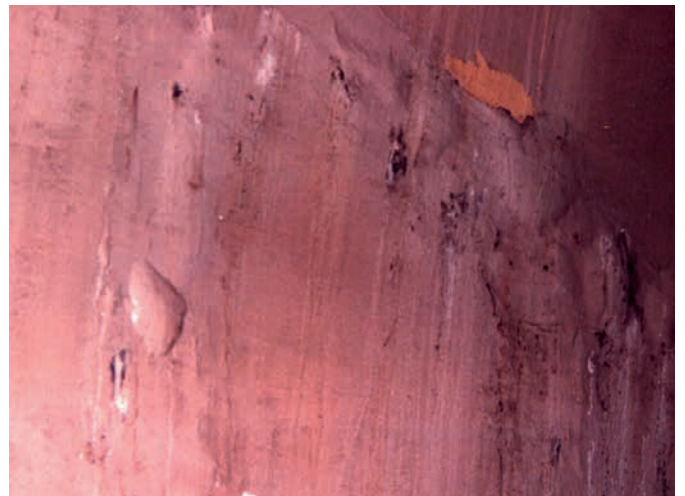
Figure 2 : cloques du film de résine avec eau sous pression
