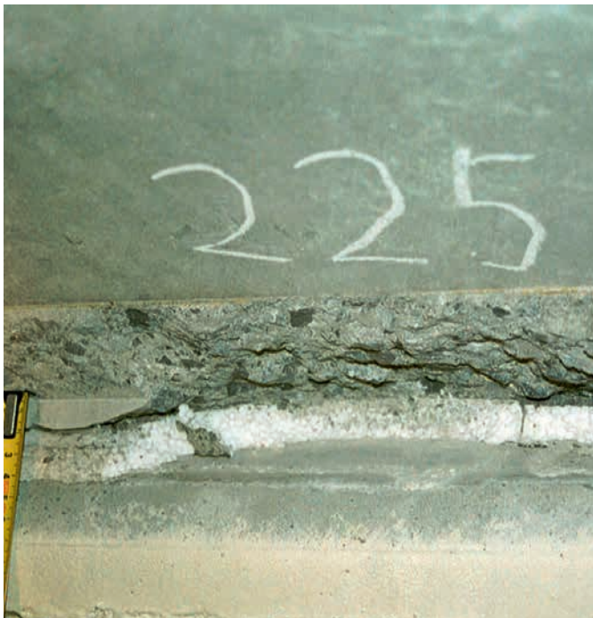
Figure 2a et 2b : épaufrures en about de dalles
