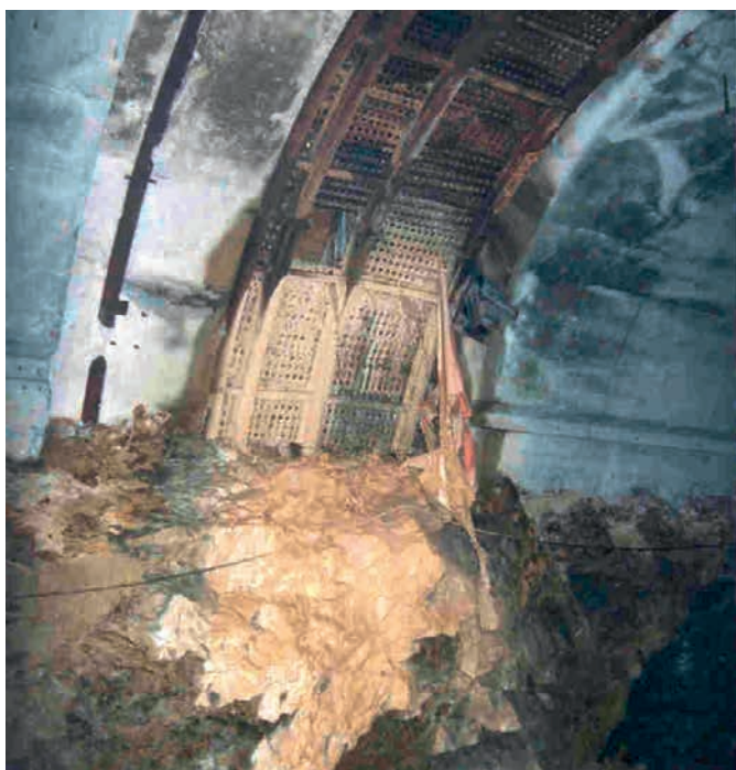
Figure 1 : concrétions calcaires encroûtantes au débouché d'un karst actif dans un tunnel abandonné
