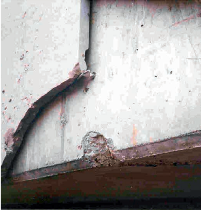
Figure 3 : rupture d'un parement due à un choc de poids-lourd
