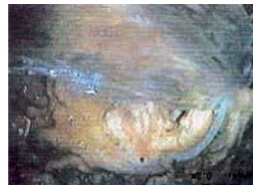
Figure 2 : vidéo-endoscopie d'un drain en PVC bouché par de la calcite
