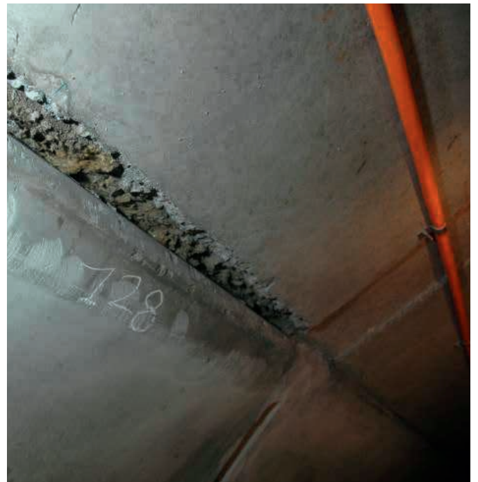
Figure 2a et 2b : épaufrures en about de dalles
