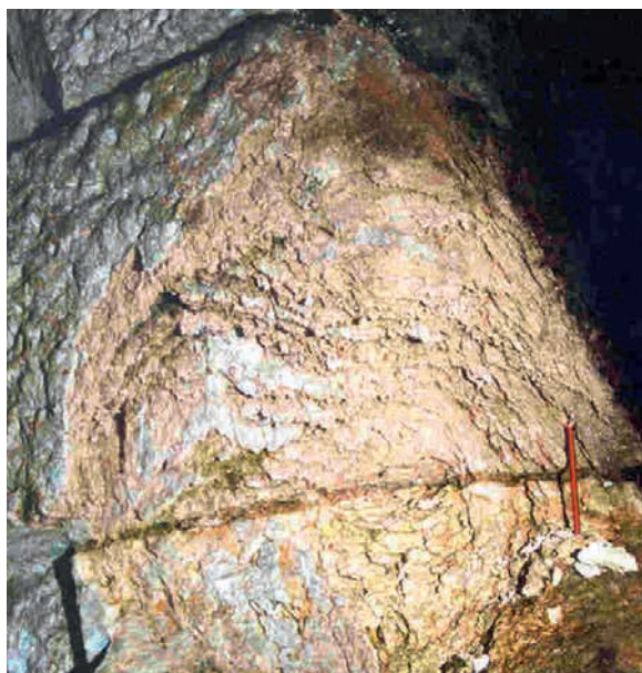
Figure 1 : effets du gel sur des pierres de taille en calcaire oolithique
