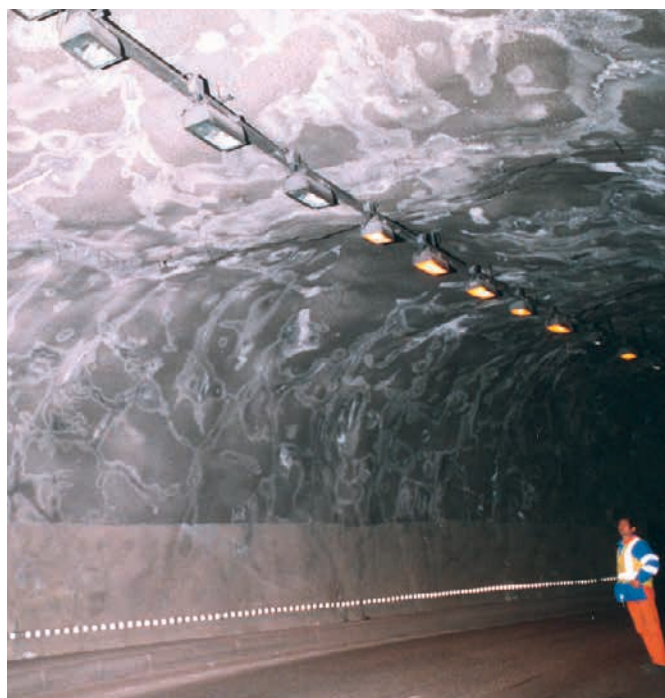
Figure 2 : même ouvrage après quelques années d'exploitation
