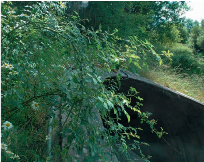
Figure 1a et 1b : végétation dense pouvant créer des instabilités aux têtes – Objets pouvant tomber sur la chaussée
