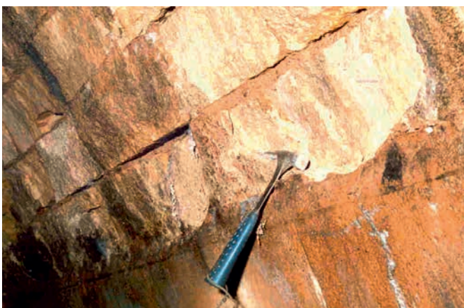
Figure 2 : exfoliations de moellons en calcaire oolithique, fragiles et gélifs
