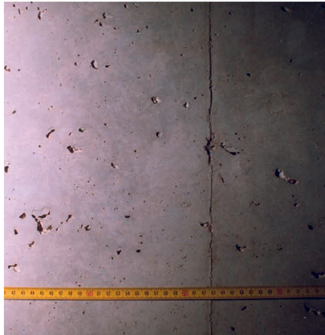
Figure 5 : bullage (ou soufflures)
