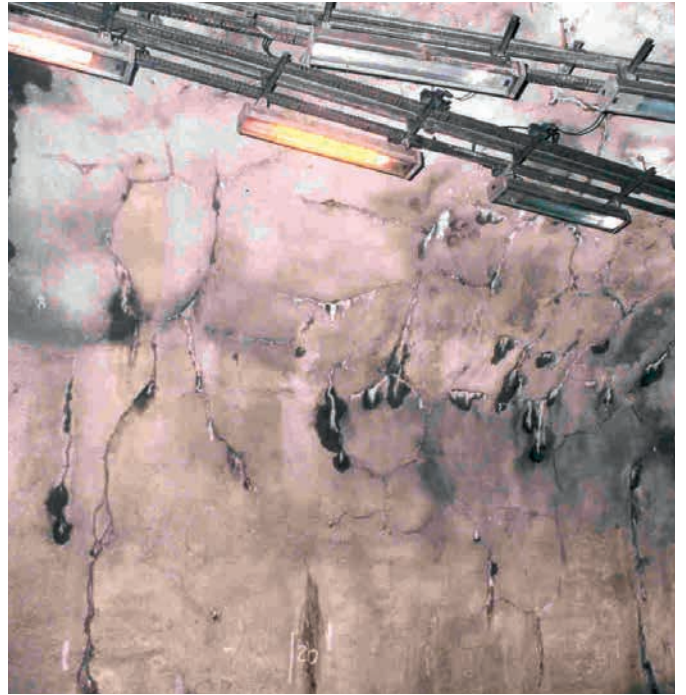
Figure 2 : faïençage d'un béton projeté sur rocher humide (retrait d'un béton non fibré)
