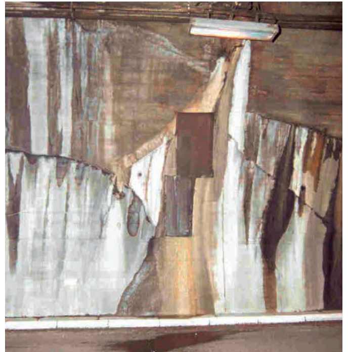
Figure 2 : expressions du retrait au sein d'un béton de 1970 sans étanchéité en extradoss
