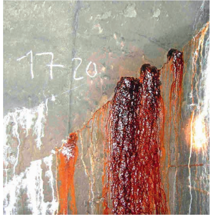
Figure 4 : fissure concrétionnée, calcite blanche et dépôts rouges-bruns
