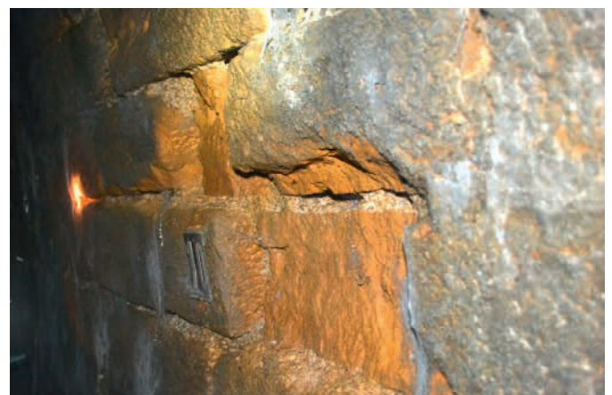
Figure 3 : exfoliation et délitage de moellons en calcaire fragile et gélif
