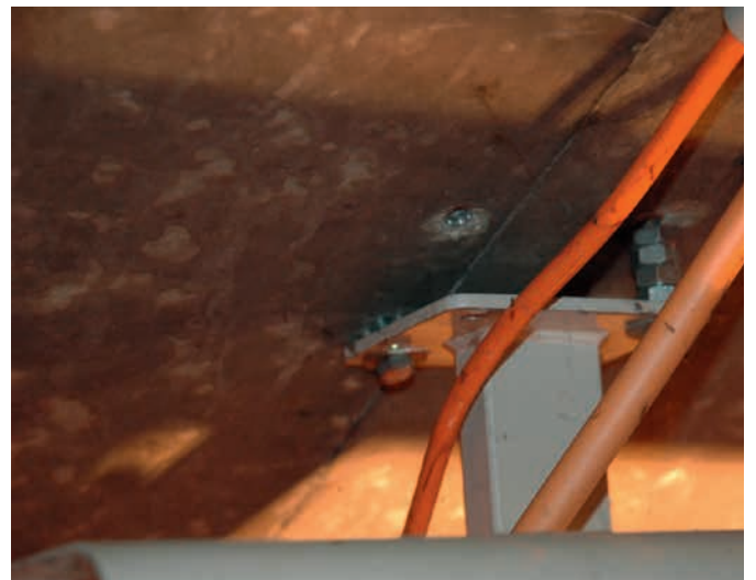
Figure 2a et 2b : fixations de suspente de chemin de câble ou de caméra sectionnées partiellement ou totalement
