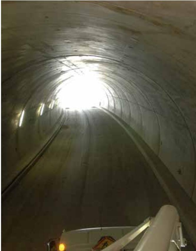
Figure 8 : revêtement en béton non armé
