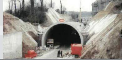
Le troisième exemple est une couverture hors sol des deux sens de circulation, à Thiais en Ile-de-France sur l'autoroute A86 (Fig. 15-16). La tranchée couverte comporte une extrémité hors sol. La surface n'est pas aménagée, laissant apparaître les piliers de l'ouvrage.
