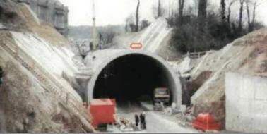
La méthode de recensement permet d'aboutir à l'identification du type d'ouvrage de chaque tronçon. Sa détermination se fait par une reconnaissance visuelle de la couverture, des piédroits et de leur liaison (cf. chapitre 3 – Classification des ouvrages).
