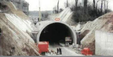
Par ailleurs, le recours à des couvertures partielles, interrompant des zones totalement couvertes, peut être judicieux pour éviter le confinement des voies sur des longueurs importantes. Ainsi, pour un même tube, l'indépendance aéraulique des différentes zones, restant couvertes sur des longueurs limitées, permet de s'affranchir des lourds équipements de sécurité qui seraient indispensables dans le cas contraire.
