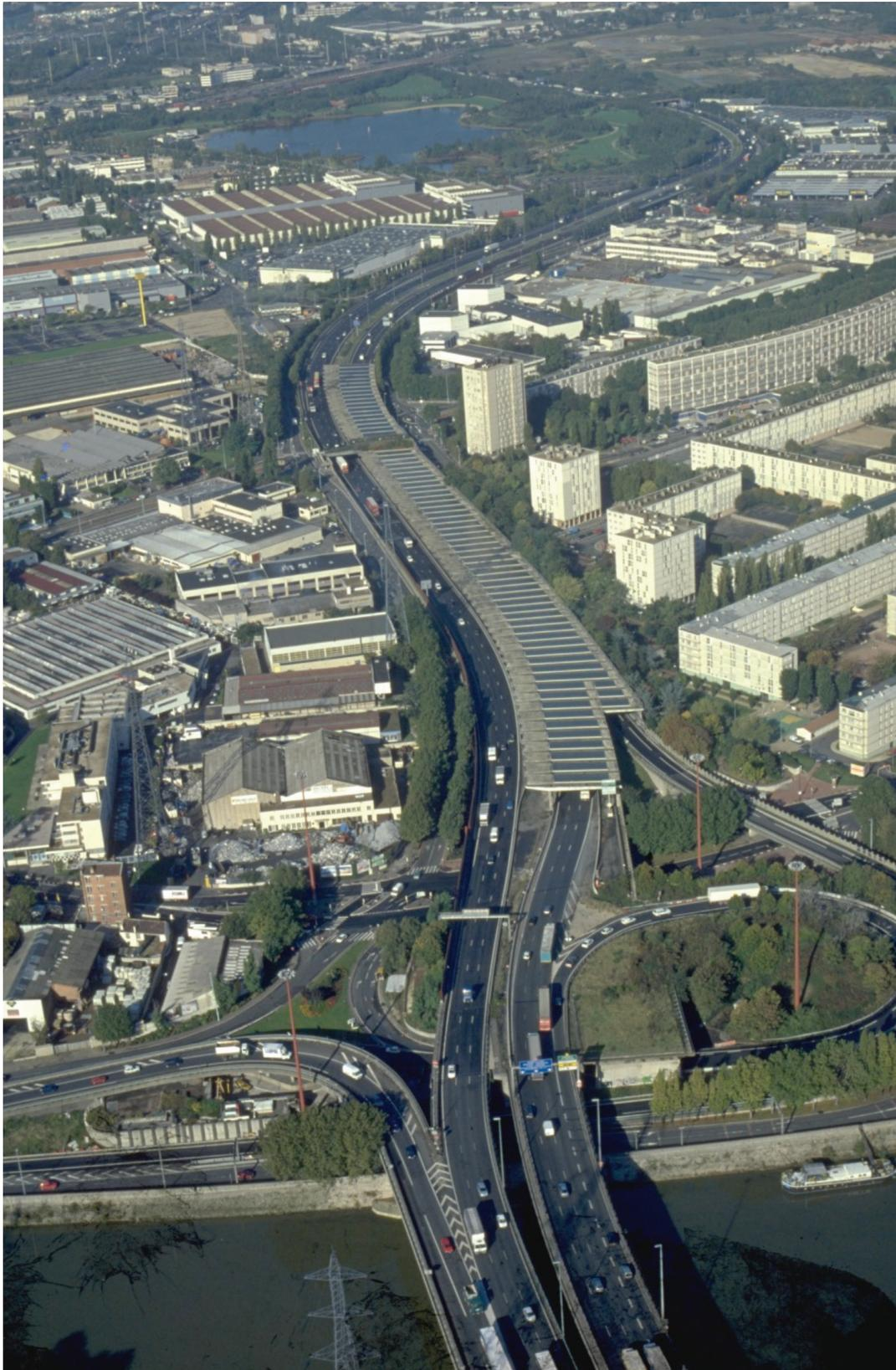
Figure 14 – Exemple de couverture hors sol sur poteaux
