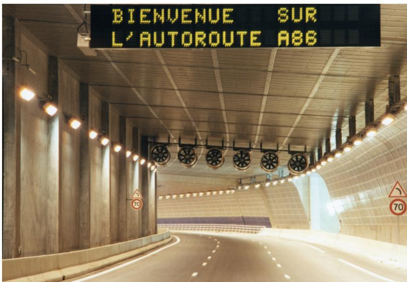
Figure 24 - PMV, système d'éclairage et batterie d'accélérateurs
