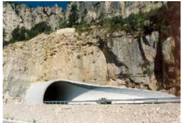
Tunnel du Pas de l'Escalette sur l'A75 (Hérault)
