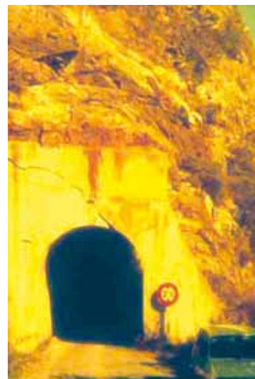
Tympan cisailé d'un tunnel dans un versant instable
