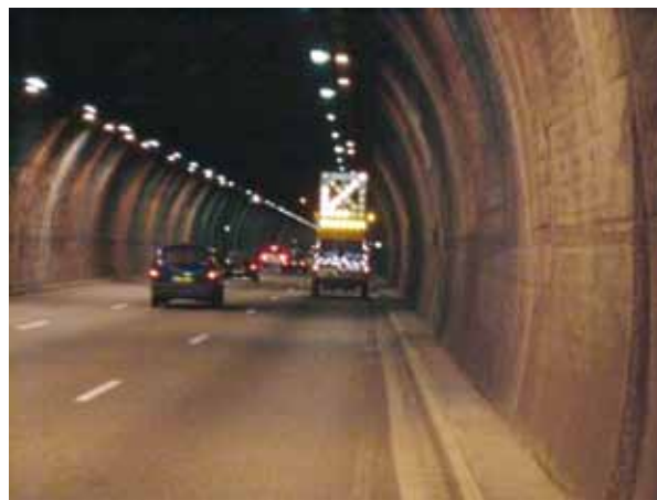
Figure 2 : Passage d'une patrouille de surveillance dans un tunnel
