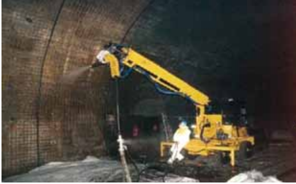
Figure 21 : Renforcement de tunnel par béton projeté
