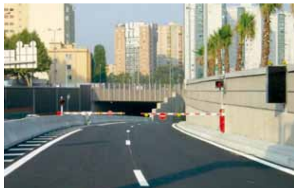
Figure 31 : Dispositif de barrières pour interdire l'accès à un ouvrage actionné lors d'essais fonctionnels
