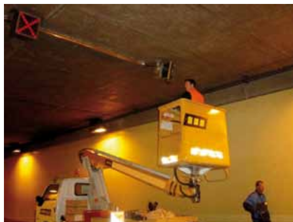
Figure 5 : Intervention de maintenance en tunnel avec un camion nacelle
