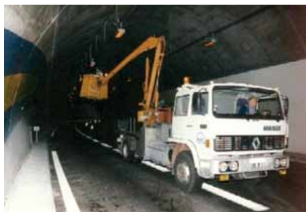
Figure 12 : Le camion-nacelle du CETU en cours d'inspection
