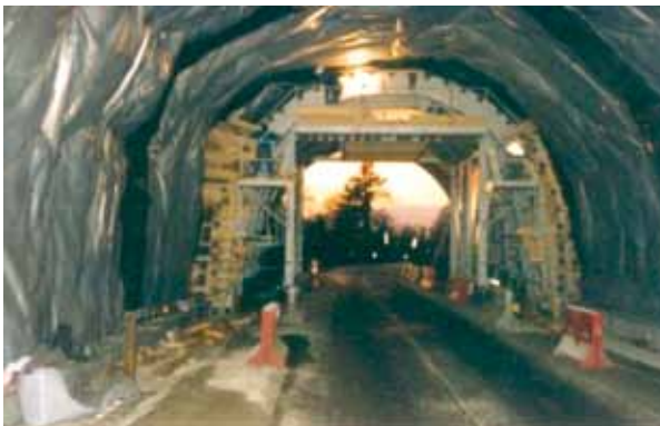
Figure 22 : Coffrage pour bétonnage après alésage et étanchement général
