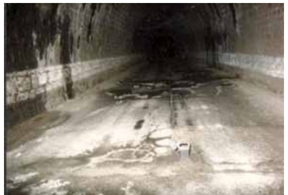
Flaches en chaussée
