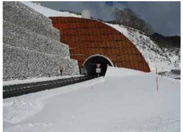
Tunnel du Lioran (Cantal)
