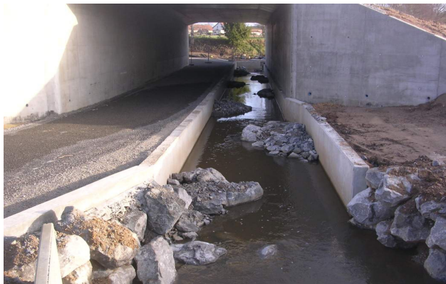
L'ouvrage en cours d'aménagement
