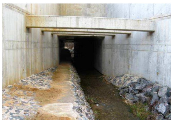
Vue   l'int rieur de l'ouvrage : fil d'eau reconstitu , banquette petite faune, luminosit  pr serv e.
