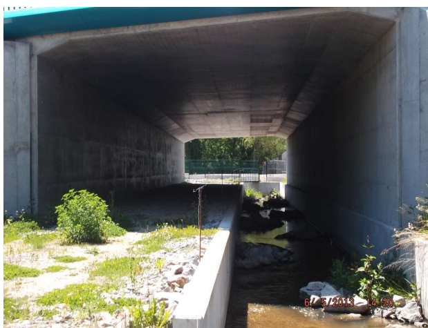
Vue depuis l'aval de l'ouvrage achevé et mis en service
