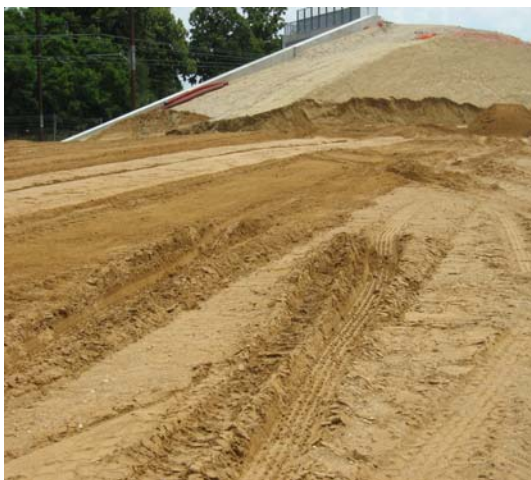
Photo 4 - Remblai courant réalisé postérieurement au remblais contigu et son remblai d'accompagnement, réalisation de redans à l'avancement (crédit : LR Blois)
