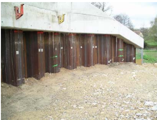
Photo 5 - Remblai contigu en cours d'ex cution. Les  paisseurs maximales des couches ont  t  not es   la peinture verte sur les palplanches m talliques (cr dit : LR de Rouen)
