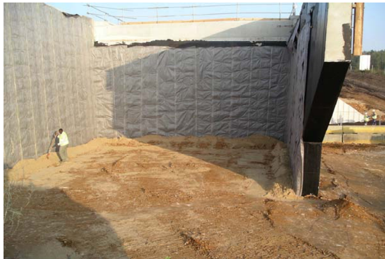
Photo 1 - Mise en œuvre d'une nappe drainante sur le badigeon de protection (en noir) d'une culée (crédit : LR de Rouen)
