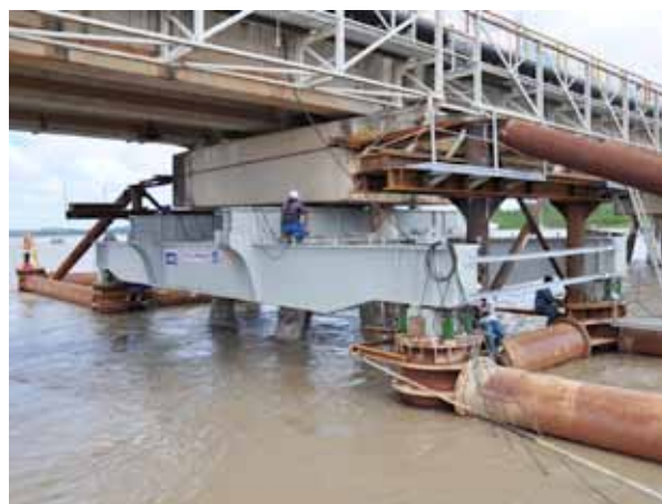
Figure 21 - Confortement d'une pile menacée d'effondrement par pose d'une charpente métallique (Photo : DEAL 973)
