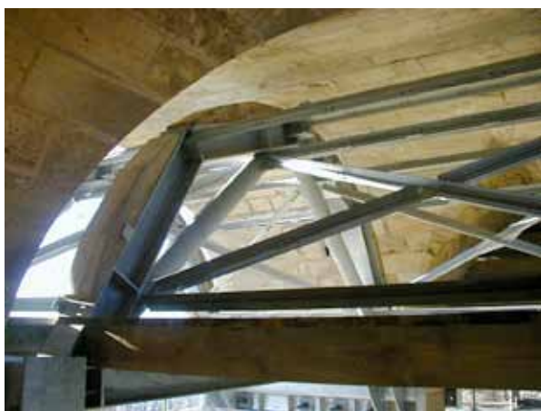
Figure 20 - Étaieement provisoire d'une voûte pour éviter son effondrement (Photo : CETE du Sud-Ouest)
