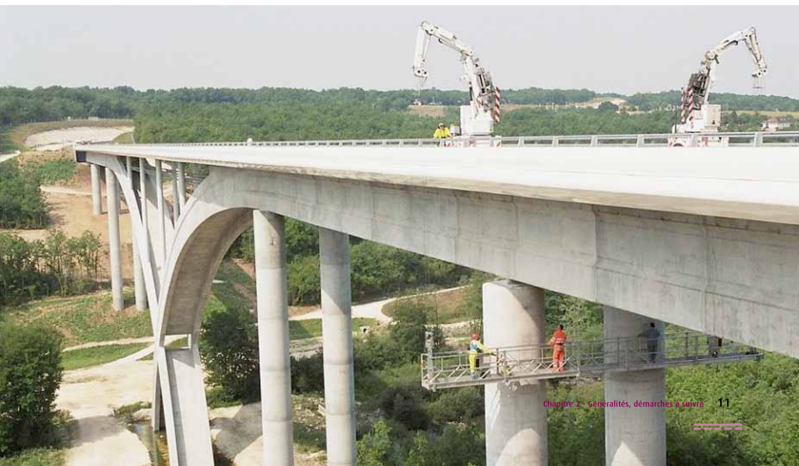
Figure 10 - Inspection détaillée des piles d'un ouvrage à l'aide d'une passerelle (Photo : CETE de Lyon)
