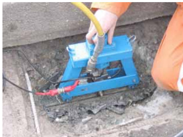
Figure 13 - Mesure de la tension résiduelle de fils de précontrainte à l'aide de la méthode de l'arbalète (Photo : LRCP de Strasbourg)
