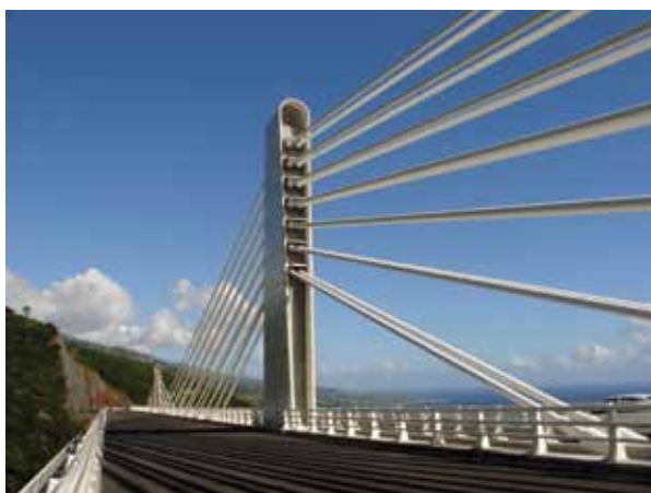
Figure 3 - Exemple d'un grand ouvrage nécessitant une attention particulière : viaduc de la Ravine des Trois bassins (île de la Réunion) (Photo : Sétra)
