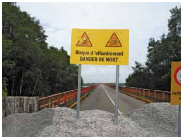
Figure 18 - Fermeture totale d'un ouvrage en urgence (Photo : Sétro)
