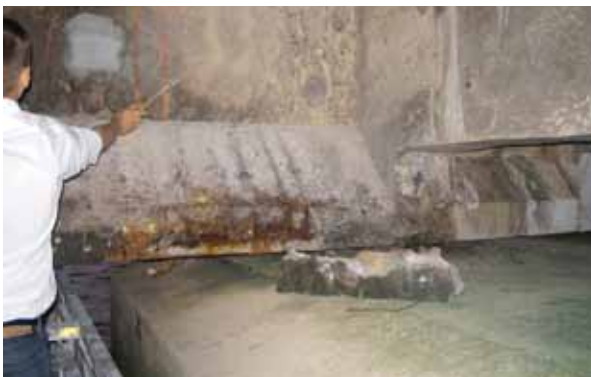
Figure 11 - Fenêtre ayant permis de déterminer l'état de la précontrainte d'un pont VIPP (Photo : Sétra)
