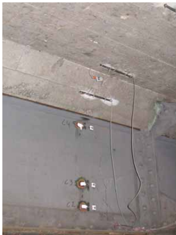
Figure 14 - Équipement d'un ouvrage mixte à l'aide de jauges de contrainte et de capteurs de déformation (Photo : CETE de l'Est)
