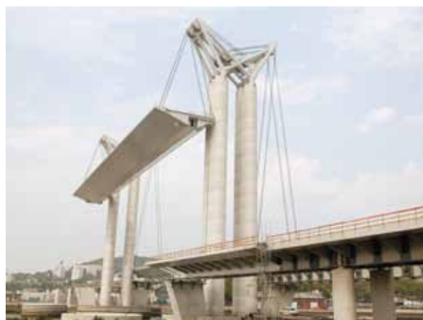
Figure 4 - Exemple d'ouvrage innovant nécessitant une attention particulière (Photo : Sétra)
