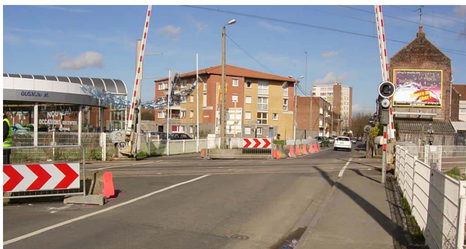
Photo 1 – Source SNCF/RFF – Exemple de chantier à proximité d'un passage à niveau
