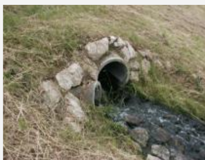
Illustration 13 : juxtaposition de deux buses traitées en point unique. Habillage en enrochement ayant à la fois un intérêt esthétique et de protection contre l'érosion (Côté Méditerranée)
