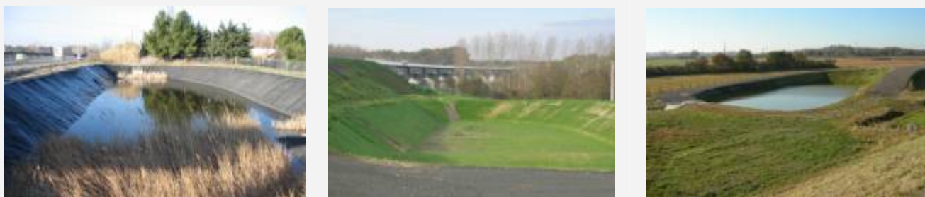
Illustration 1 : exemples de bassin d'assainissement bien con u techniquement mais sans recherche d'insertion vis- -vis du site d'implantation, que ce soit au niveau de la conception (lien avec le relief, am nagement de proximit , choix des rev tements ou de la forme, etc.) ou de l'exploitation (gestion de la v g tation, du mobilier, etc.).
