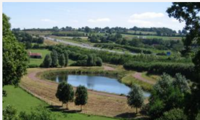
Illustration 7 : exemple de choix d'insertion du bassin en fonction de la topographie et la géographie du lieu (accompagnement végétal, forme harmonieuse, etc.)- Autoroute A84 (Cété Normandie-Centre)
