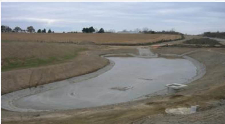
Bassin après construction. Choix d'un revêtement granulaire des pentes et du chemin d'accès avec les matériaux du site.
