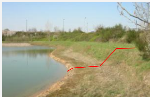
Illustration 5 : autre forme de bassin possible avec un redan au droit des berges. Dans ce cas, la partie basse peut se remplir d'eau en cas de fortes pluies (zone de rabattement d'eau) (Côté de l'Ouest).
