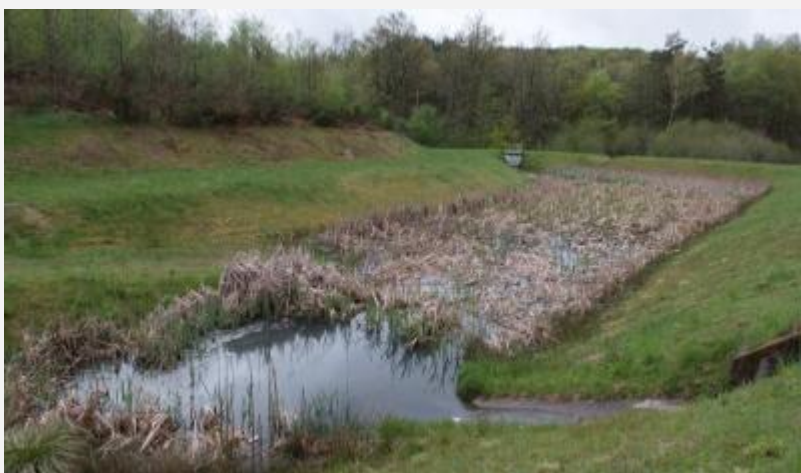
Fonctionnement d'un bassin. Bassin après colonisation végétale du fond et des pentes - A89 (ASF)
