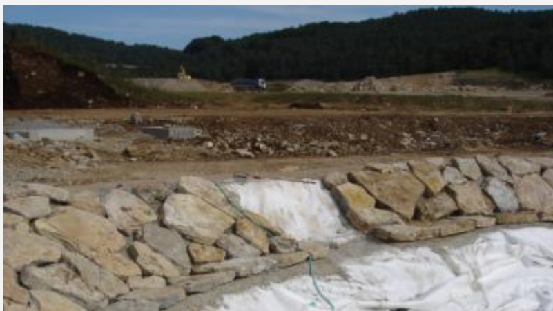
Bassin en phase Chantier. Empierrement du contour du bassin sur une couche géomembrane pour garantir l'étanchéité. Au-delà de l'aspect technique, il en découle un intérêt esthétique.
