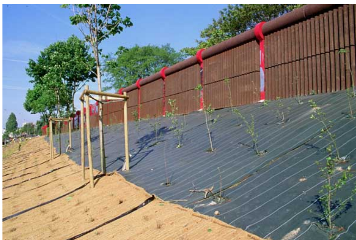
Illustration 13 - Plantations accompagnant la mise en place de protections acoustiques sur l'autoroute A15 à Sannois (DREIF/GOBRY)
