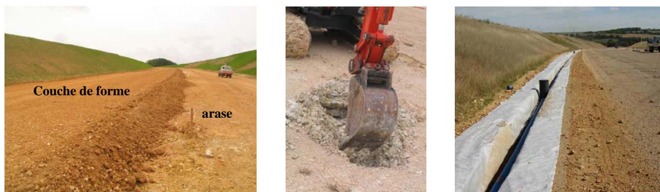
Figures 7, 8 et 9 : r ception des arases dans un d blai avant mise en  uvre de la couche de forme - sondages pour confirmation de la nature des sols constituant la PST – r alisation du drainage de la PST (photos: LRPC Blois).
