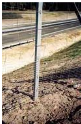
Photo 3 : Treillis soudé à mailles progressives [200-30-15] - Source : J. Carsignol (Cete de l'Est)
