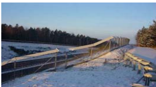
Photo 9 : Clôture adaptée au lynx : simple torsion (30 x 30 mm), barrière métallique enterrée de 0,50 m, bavolet de 0,30 m en plastique recyclé - Source : M. Hermann (Öko-Log).
