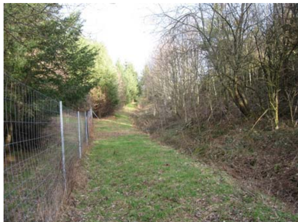
Photo 11 : Un fauchage doit permettre de faciliter les visites de vérification de l'intégrité de la clôture – Source : ASF
