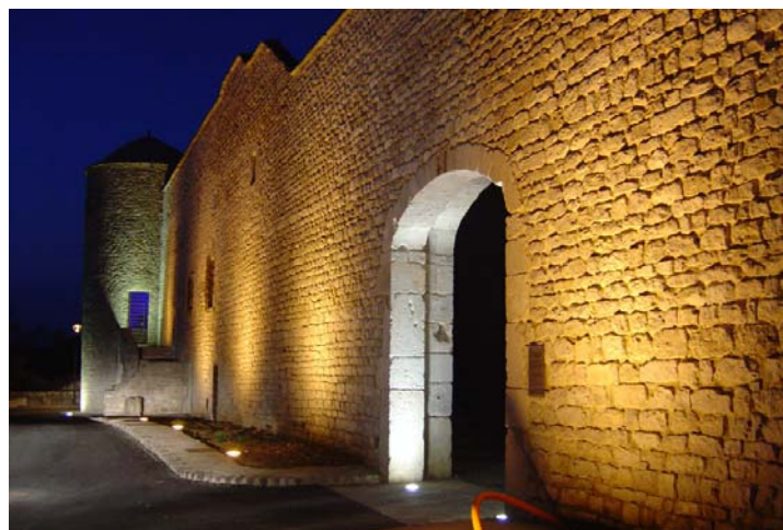
Après travaux de rénovation des remparts et mise en lumière
