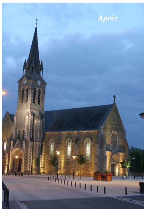
Commune d'Yvré l'Évêque, département de la Sarthe : éclairage et requalification de la place de l'Église (source : Cofiroute)
