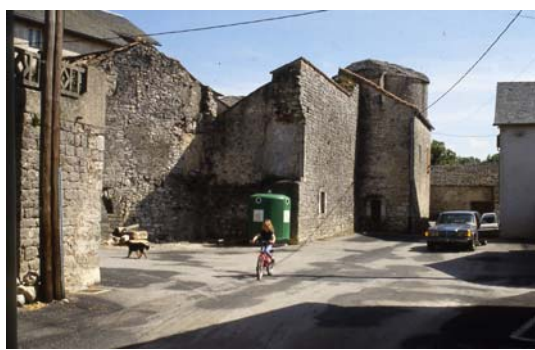
Remparts Ouest avant rénovation : habitations privées, ouvertures créées (fenêtres, portes), murs abattus,...
