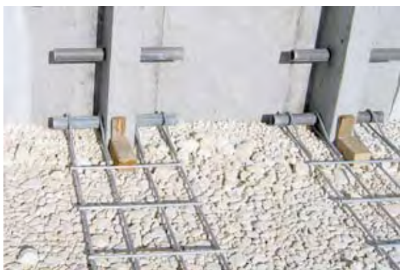
Photos 3 : exemples de systèmes de fixation des armatures au parement
