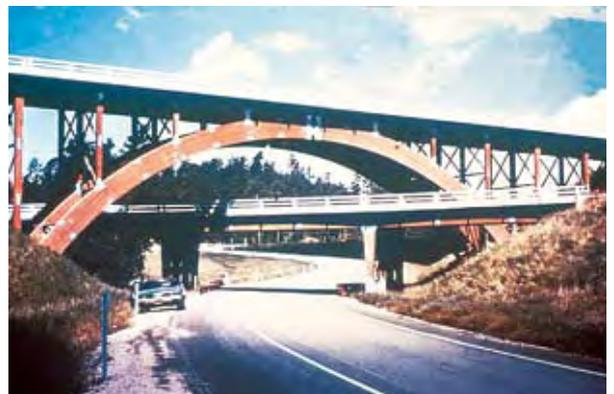
Photo 6 : pont de Keystone-Wye dans le Sud-Dakota. Arc lamellé-collé à l'abri sous une dalle (1968) – Source : Prof. Gutkowski (Colorado State University)
