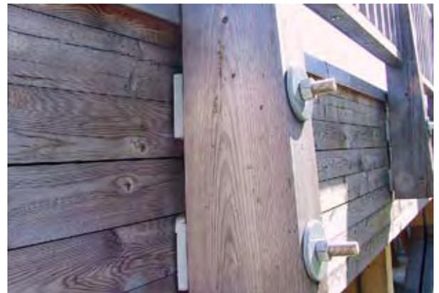
Photo 66 : minimisation des surfaces de contact
