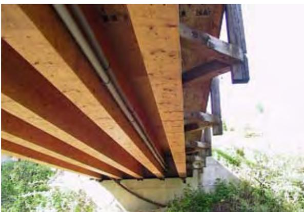
Photo 58 : poutres sous chaussée protégées des intempéries
