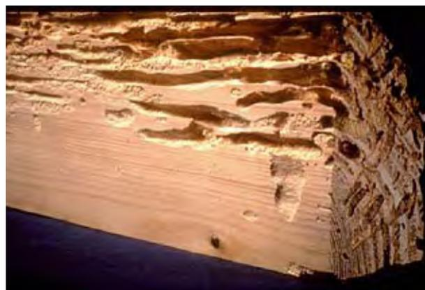
Photo 24 : dégâts dus au capricorne – Source : CNDB
