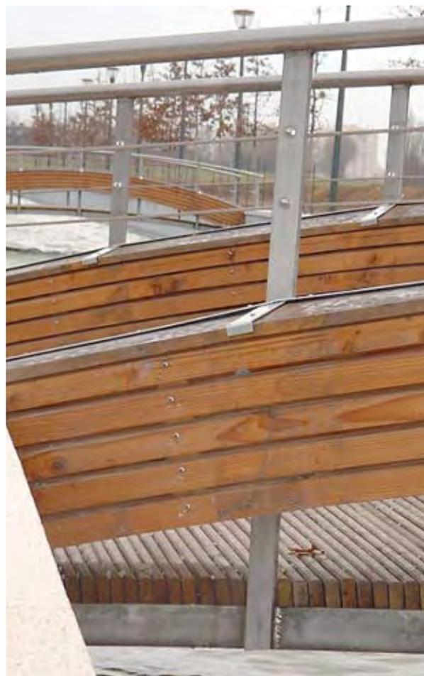
Photo 45 : détail de platelage à chant et bardage à clair voie
