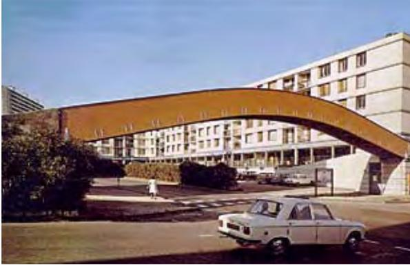
Photo 7 : passerelle Cocteau construite à Nîmes. Arc lamellé-collé sans protection vis-à-vis des chocs et de la pluie (1975)
