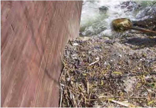
Photo 55 : accumulation de terre au contact du bois
