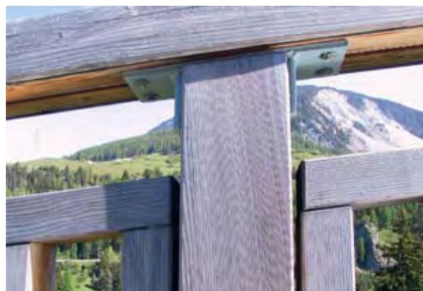
Photo 64 : exemple de fixation de main courante
