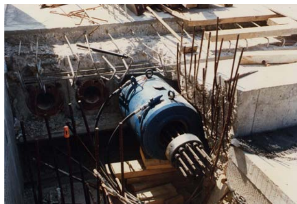
Mise en tension d'une unité de précontrainte (Photo : G. Forquet)
