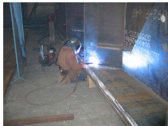
Soudage semi automatique en angle (photo CETE Est)
