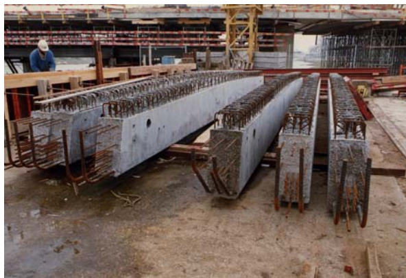
Poutres préfabriquées (Photo G. Forquet – Sétra)
