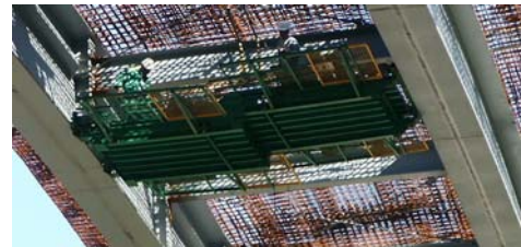
Photo CETE SO Plate-forme en partie centrale
