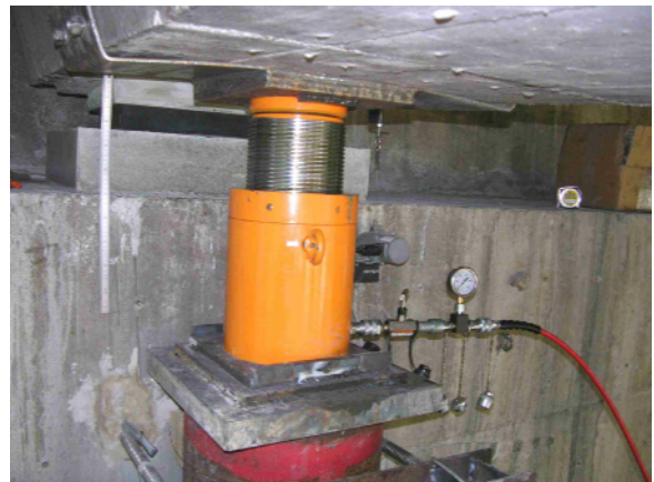
Opération de vérinage d'un tablier (photos LRPC de Clermont-Ferrand)
