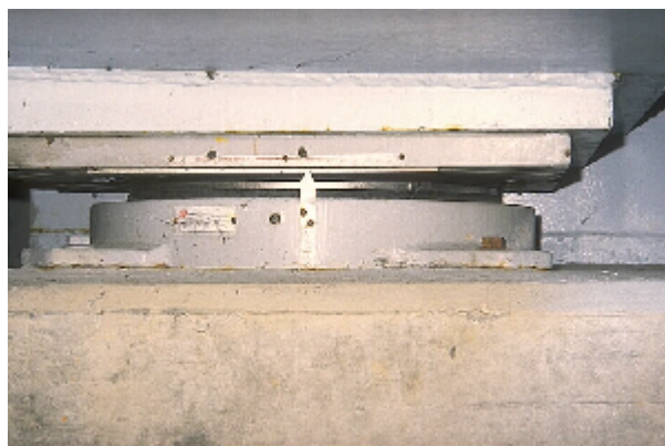
Appareil d'appui à pot (Photo Sétra/CTOA)
