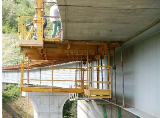
Photo CETE SO Plate-forme en encorbellement
