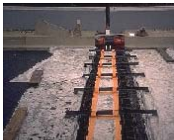
joint de chaussée avant bétonnage (photo Sétra/CTOA)
