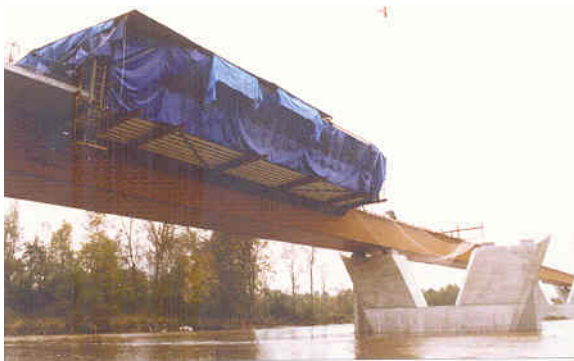
Photo Sétra – G. FORQUET Abri de protection du pont de Nevers
