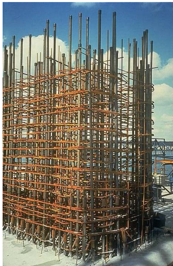
Cage d'armatures (Photo Sétra/CTOA)
