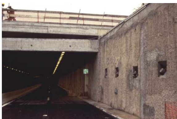
Paroi moulée ancrée servant de soutènement (photo LRPC de Lyon)
