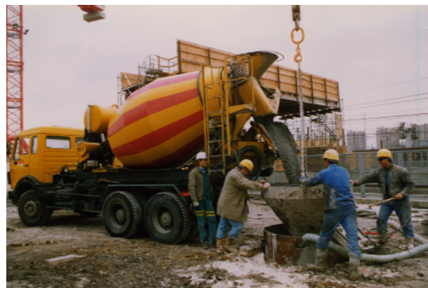
Bétonnage d'un pieu (photo G. Forquet - Sétra)
