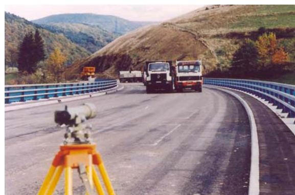
Mesure de nivellement (photo LRPC de Strasbourg)
