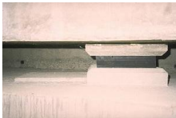
Appareil d'appui en élastomère fretté avec bossages et emplacement pour le vérinage (Photo Sétra/CTOA)
