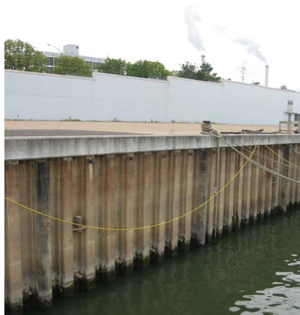
Rideau de palplanches (photo LRPC de Lyon)
