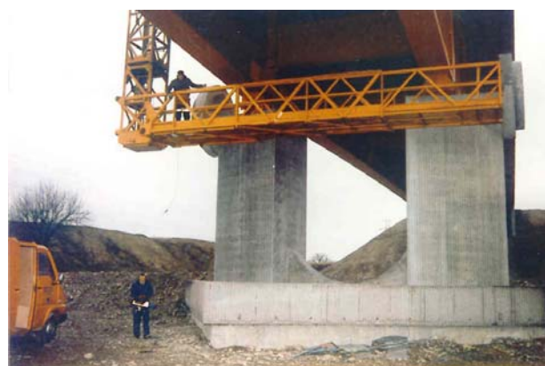
Passerelle d'inspection (photos LRPC de Strasbourg)
