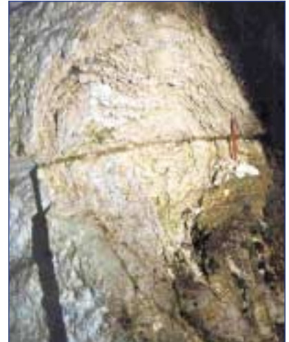
Effet du gel sur des pierres de taille de calcaire oolithique
