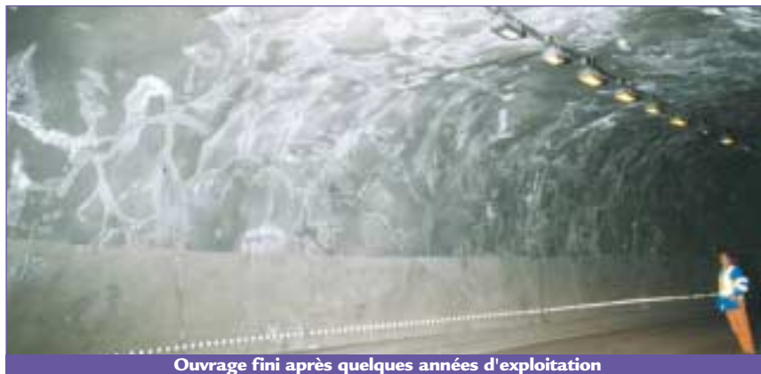
Ouvrage fini après quelques années d'exploitation
