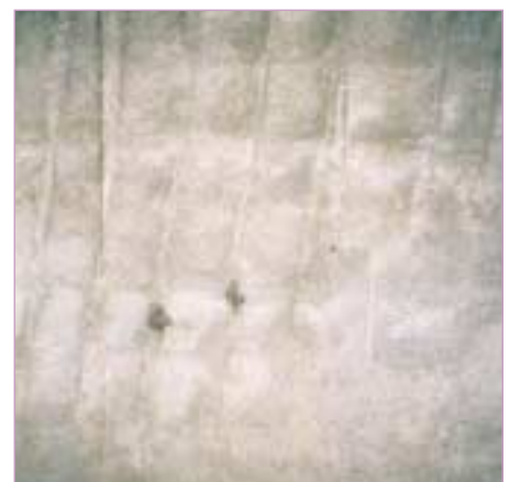
Spectre des armatures en piédroit
