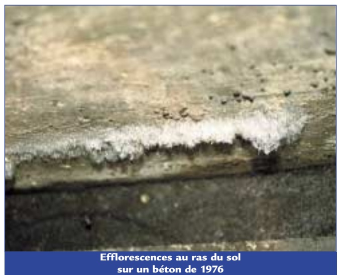
Efflorescences sur mortiers anciens à base de chaux
