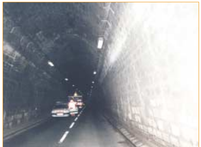
La partie claire (méplat) a perdu sa courbure d'origine
