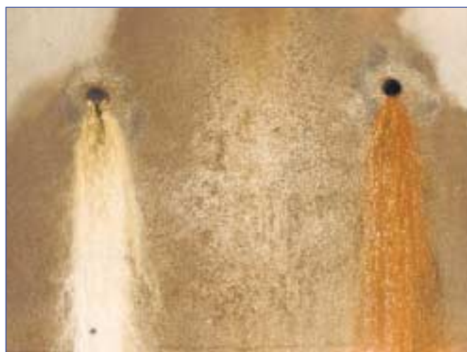
À gauche : concrétions claires de calcite À droite : dépôt de gel rouge, riche en oxyde de fer
