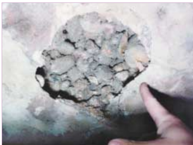
Nid de cailloux initialement masqué par une pellicule de laitance. Son étendue ne peut être cartographiée qu'à l'auscultation au marteau
