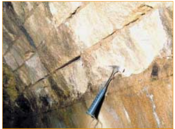
Exfoliations de moellons de calcaire oolithique, fragiles et gélifs
