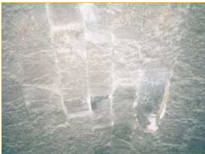
Écaillage de moellons en clé
