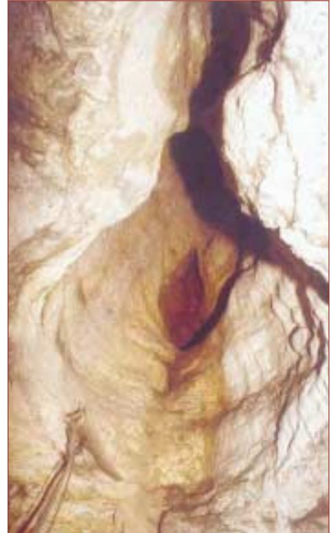
Conduit ouvert débouchant en calotte d'un tunnel non revêtu; on distingue les traces d'écoulements temporaires mêlés d'argile rouge
