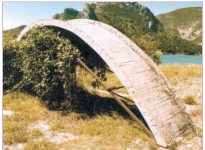
Élément avec son armature de manutention
