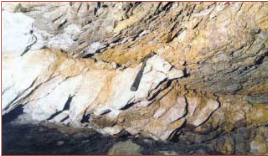
Masse de roche fracturée séparée du terrain par un joint argileux (on parlera ici de « pont de roche instable »). Une purge est possible, dans un premier temps
