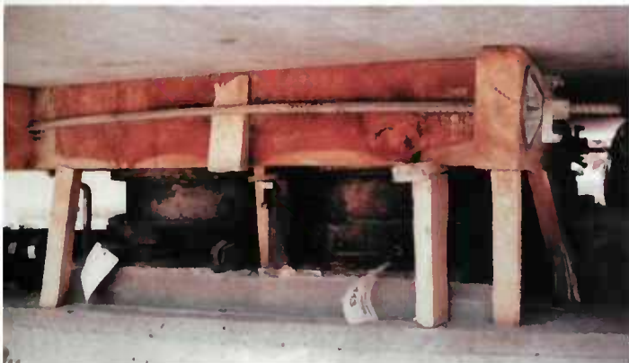
Fig. 5.30 - Calage provisoire réalisé par des boîtes à sable
