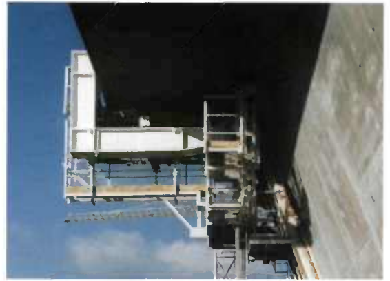
Fig. 6.8 - Poutres porteuses en appui sur l'extrémité de poutres supérieures en C.
