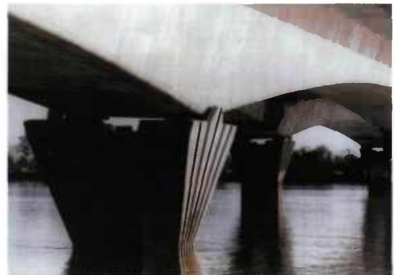
Fig. 1.16 - Le pont d'Arcins, à Bordeaux
