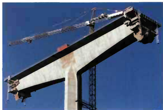
Fig. 5.11 - Encastrement du fléau sur pile
