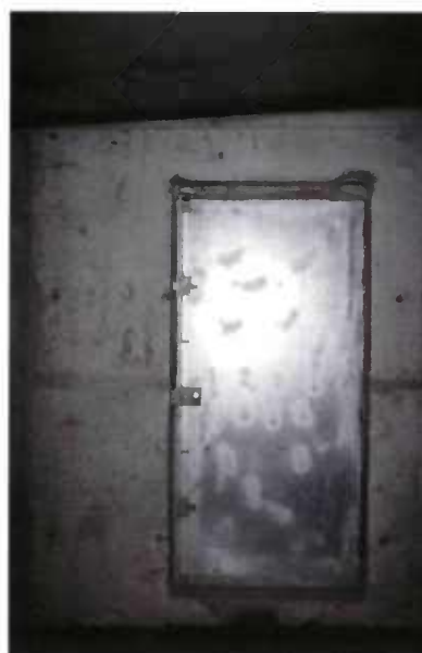
Fig. 9.11 - Porte d'accès à une pile ou une culée avec cinq points d'ancrage
