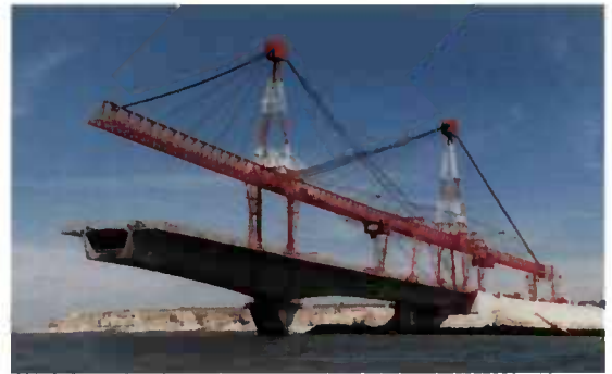
Fig. 6.36 - La poutre de lancement haubanée du viaduc de l'île de Ré
