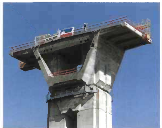
Fig. 5.16 - Clouage d'un voussoir sur pile coulé en place
