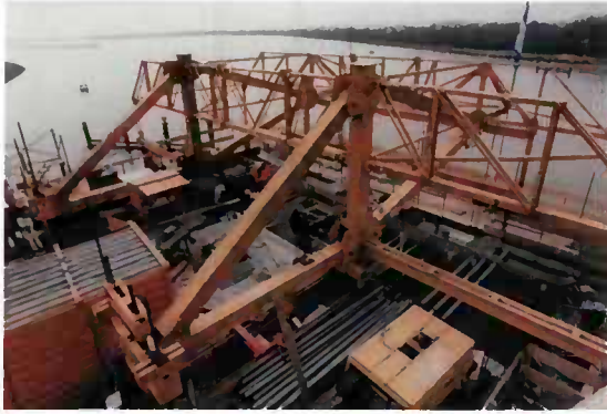
Fig. 6.4 - Dégagement vers le haut d'un équipage mobile "par-dessus"
