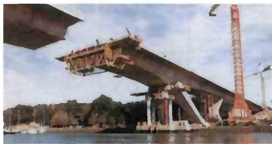
Fig. 1.7 - Construction du pont à bécquilles d'Auray
