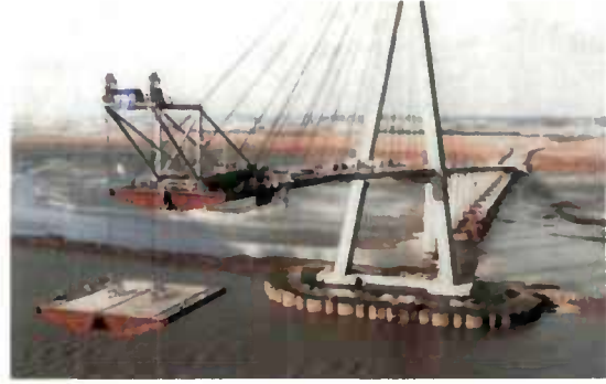
Fig. 1.4 - Le pont de Normandie
