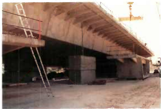
Fig. 5.6 - Contrepoids de stabilité d'un fléau
