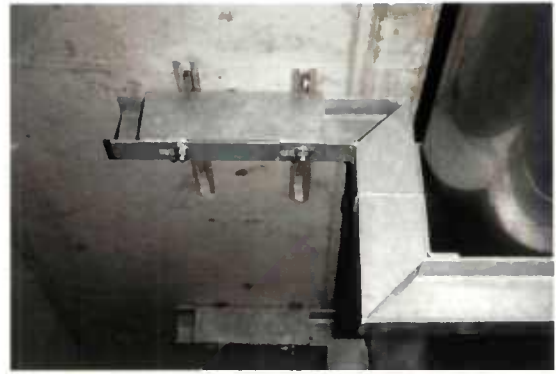
Fig. 9.16 - Fixation d'un chêneau
