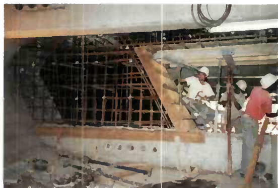
Fig. 6.16 - Exécution en seconde phase des voiles déviateurs
