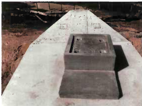
Fig. 9.9 - Bossage concrétisant un emplacement de vérinage
