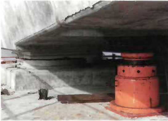
Fig. 5.14 - Vérins de calage et de réglage et appareil d'appui définitif
