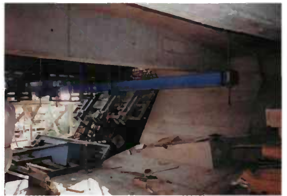
Fig. 6.10 - Poutre-tiroir déplaçable manuellement
