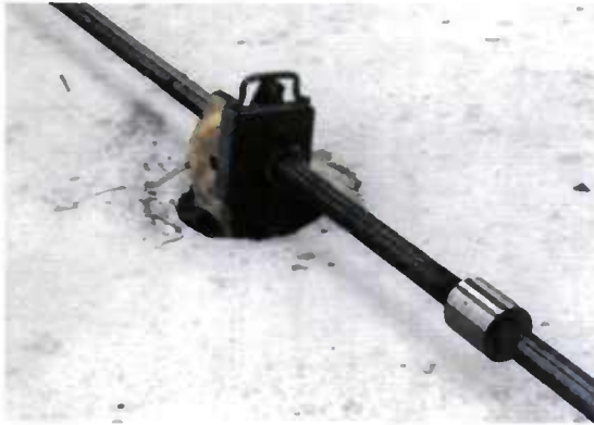
Fig. 6.41 - Ancrage par sabot d'une barre de brélage
