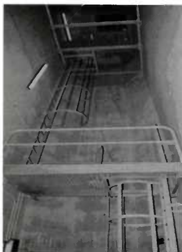
Fig. 9.10 - Échelles à crinolines et paliers à l'intérieur d'une pile
