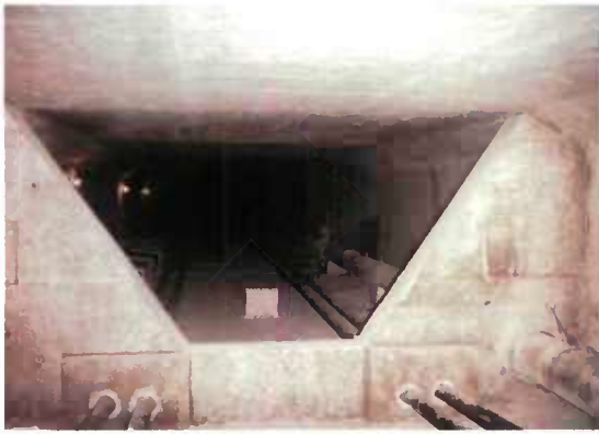
Fig. 8.6 - Précontrainte longitudinale additionnelle
