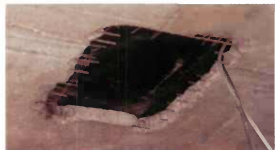
Fig. 9.6 - Percement d'un hourdis inférieur rendu nécessaire par l'absence de trappe d'accès
