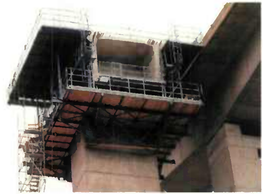
Fig. 6.2 - Plancher de travail pour coffrage des voussoirs sur piles
