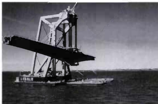
Fig. 1.21 - Transport d'un fléau préfabriqué du pont de la Confédération
