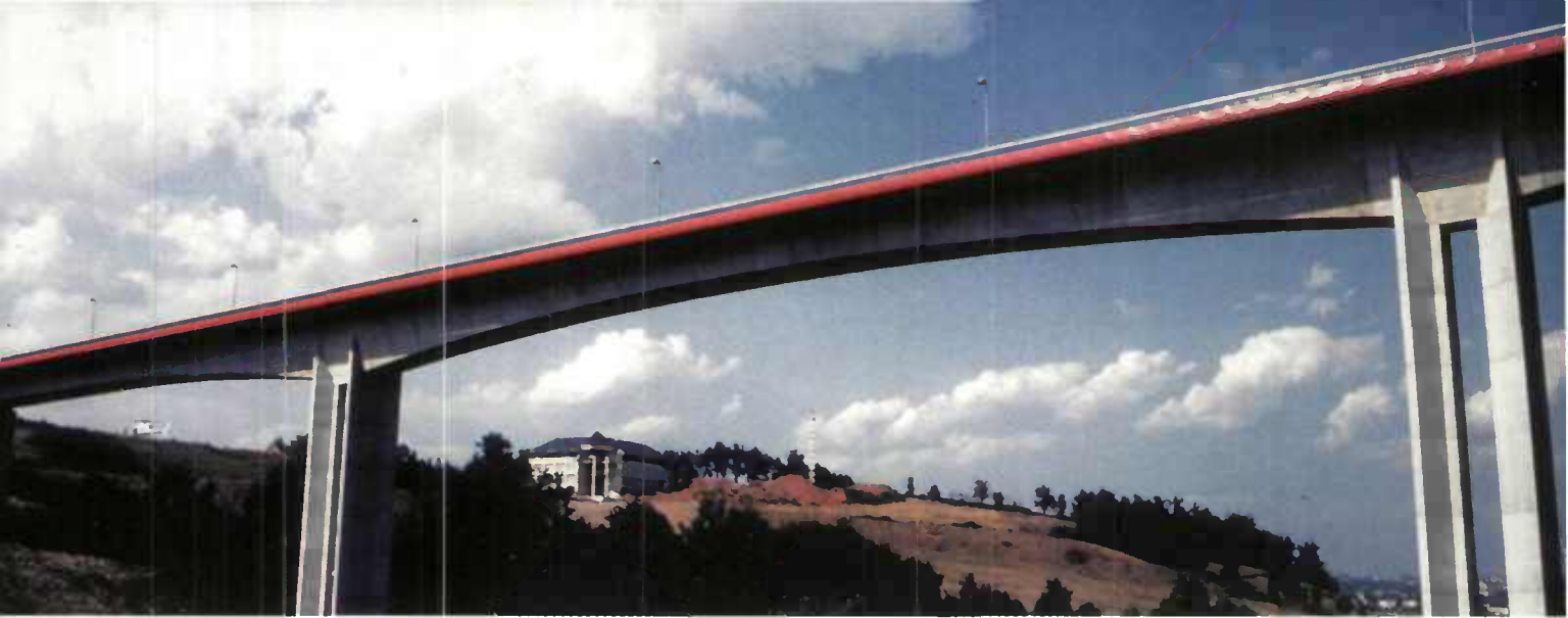
Fig. 5.12 - Pile à fûts dédoublés
