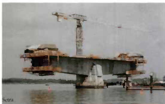
Fig. 1.6 - Construction par encorbellements successifs de tabliers en caisson en BP avec voussoirs coulés en place, à gauche, et préfabriqués, à droite
