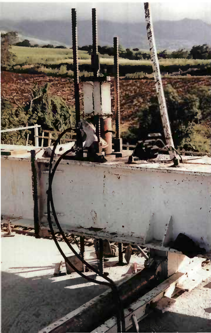
Fig. 6.9 - Poutre supérieure avec vérin à longue course (en bas de la photo)
