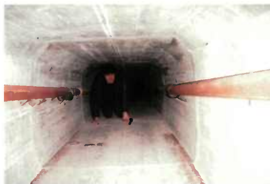
Fig. 9.1 - Exemple de caisson très petit
