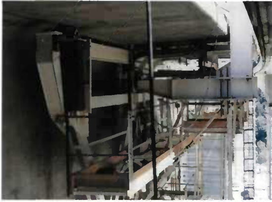
Fig. 6.8 - Poutres porteuses en appui sur l'extrémité de poutres supérieures en C.
