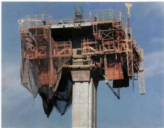
Fig. 5.21 - Équipage mobile en cours de déplacement
