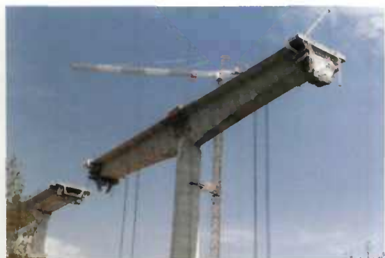
Fig. 5.9 - Haubanage d'un fléau du pont de Tanus
