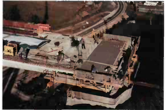
Fig. 6.5 - Dégagement vers le haut d'un équipage mobile "par-dessus"
