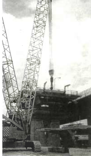
Fig. 6.38 - Pose à la grue terrestre
