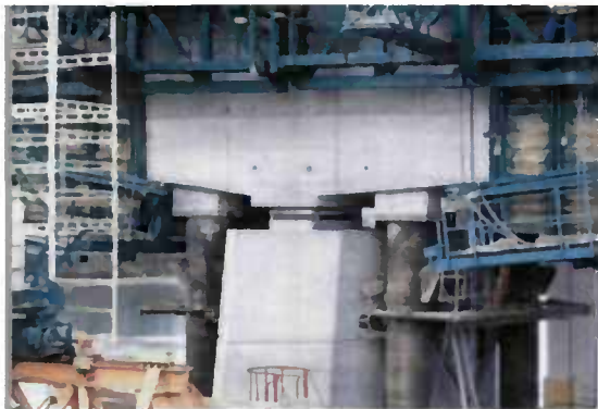
Fig. 6.22 - Stabilisation d'un fléau par palées tubulaires métalliques
