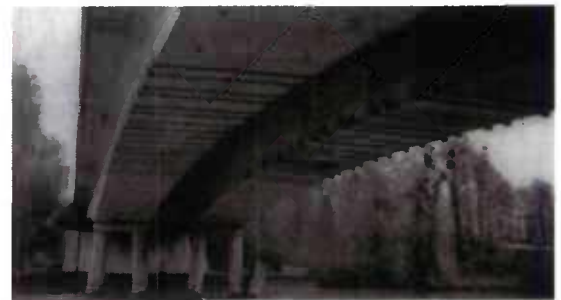
Fig. 8.8 - Précontrainte transversale additionnelle du hourdis inférieur
