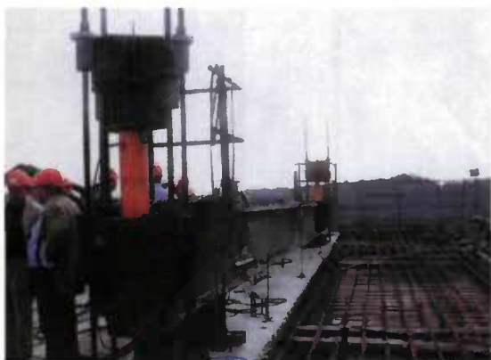
Fig. 6.14 - Poutre supérieure sans console
