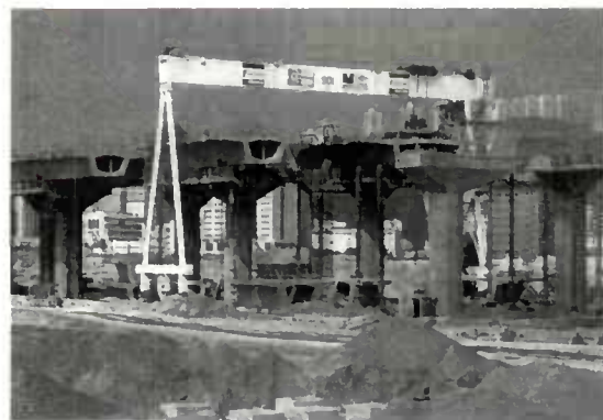
Fig. 6.40 - Pose au portique
