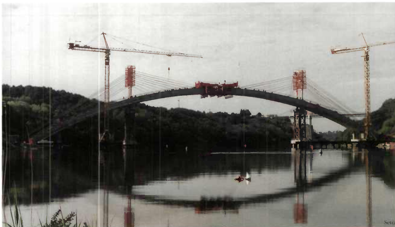
Fig. 1.9 - Le pont en arc de la Roche-Bernard en construction
