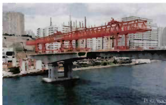
Fig. 1.6 - Construction par encorbellements successifs de tabliers en caisson en BP avec voussoirs coulés en place, à gauche, et préfabriqués, à droite
