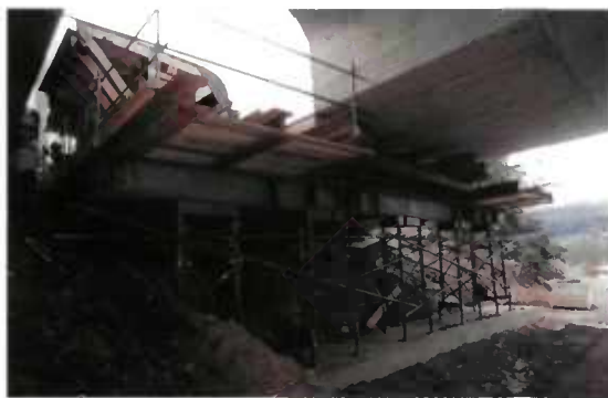
Fig. 6.17 - Construction sur étaielement du tronçon d'extrémité d'une travée de rive
