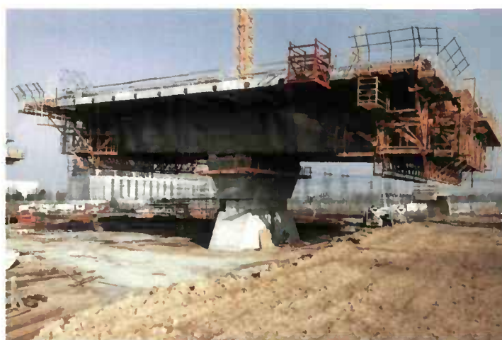
Fig. 5.2 - Clouage de stabilité par précontrainte
