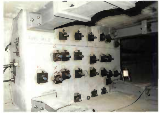
Fig. 8.7 - Massif d'ancrage pour précontrainte longitudinale additionnelle
