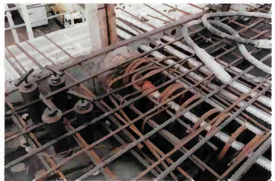
Fig. 6.24 - Bloc d'about cylindrique en place dans l'équipage
