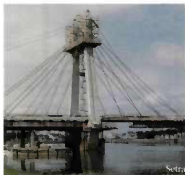
Fig. 1.8 - Le pont à haubans de Chalon-sur-Saône en construction
