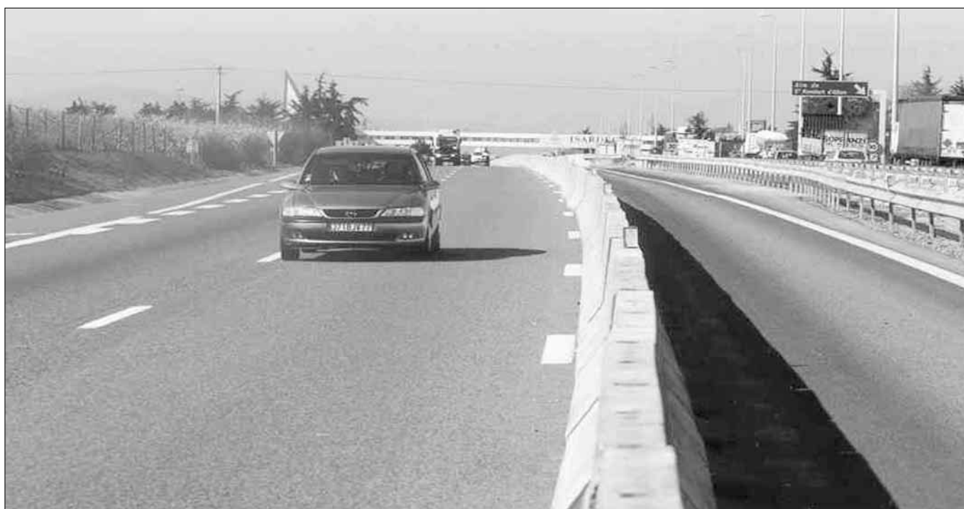
Séparateur modulaire de voies en béton.
