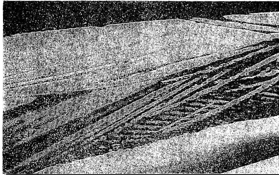
Fils rompus 1 re et 2 e couches. Hauban aval intérieur. Pile rive droite.
