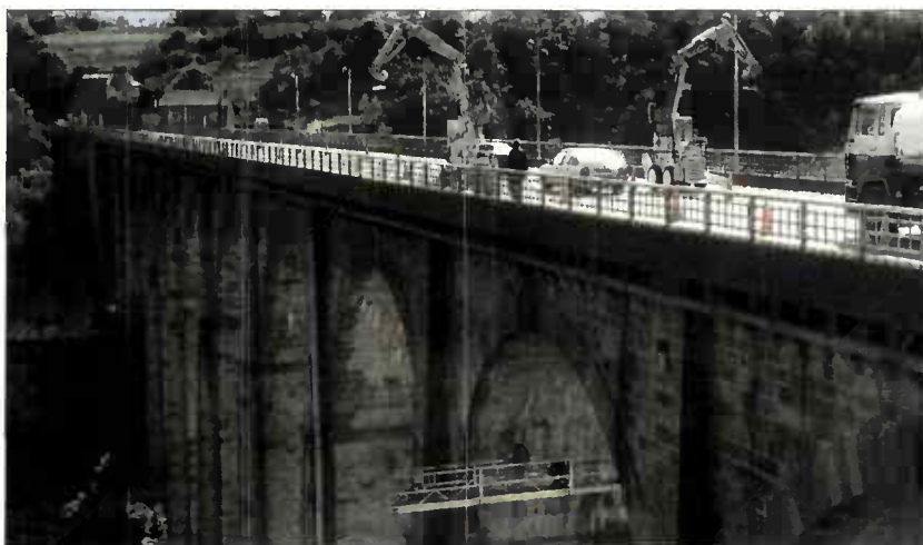
Fig. 9 - La passerelle EPSILON du Centre d'études techniques de l'Équipement de Lyon en position sur un ouvrage en maçonnerie dans le cadre d'une inspection détaillée.
