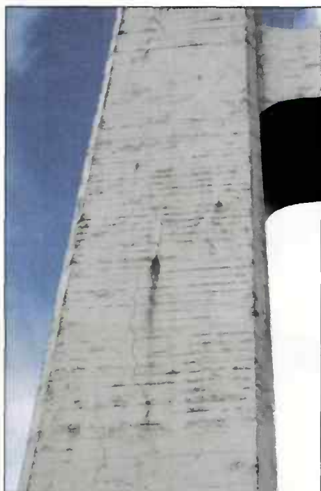
Fig. 8 - Cas d'un autre ouvrage dans un état douteux : fissuration longitudinale en sous-face de talon d'un VIIP, accompagnée d'efflorescences et de stalactites témoignant d'une circulation d'eau dans les gaines de précontrainte.
