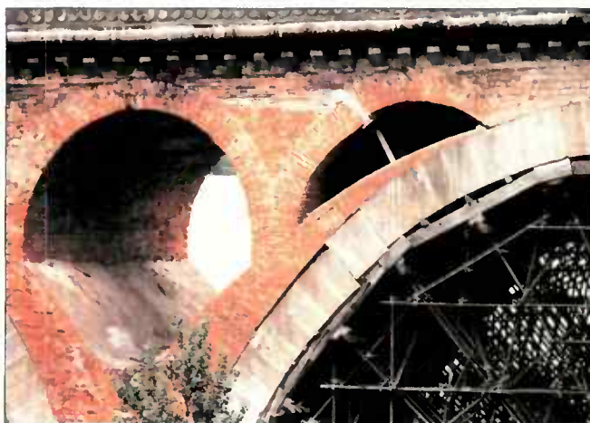
Fig. 20 : Étaie provisoire d'une voûte en maçonnerie pour éviter son effondrement.
