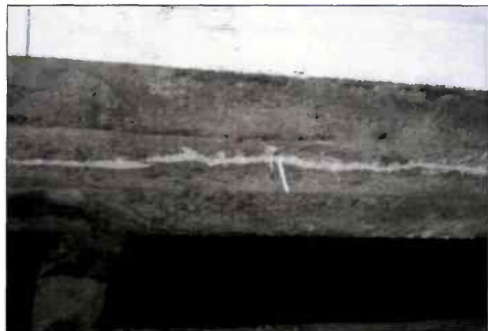
Fig. 8 - Cas d'un autre ouvrage dans un état douteux : fissuration longitudinale en sous-face de talon d'un VIIP, accompagnée d'efflorescences et de stalactites témoignant d'une circulation d'eau dans les gaines de précontrainte.
