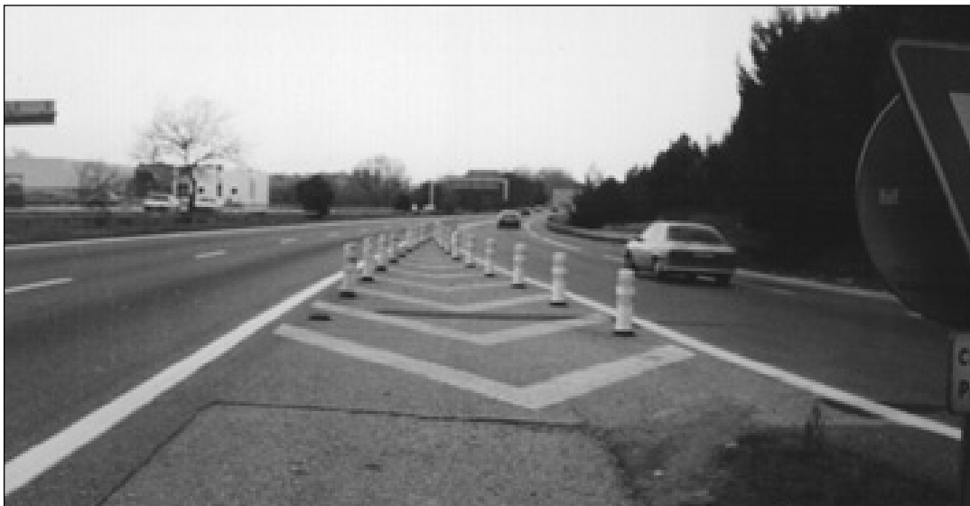
Photo 3 : Exemple d'implantation de balises souples J 11 en convergent.
