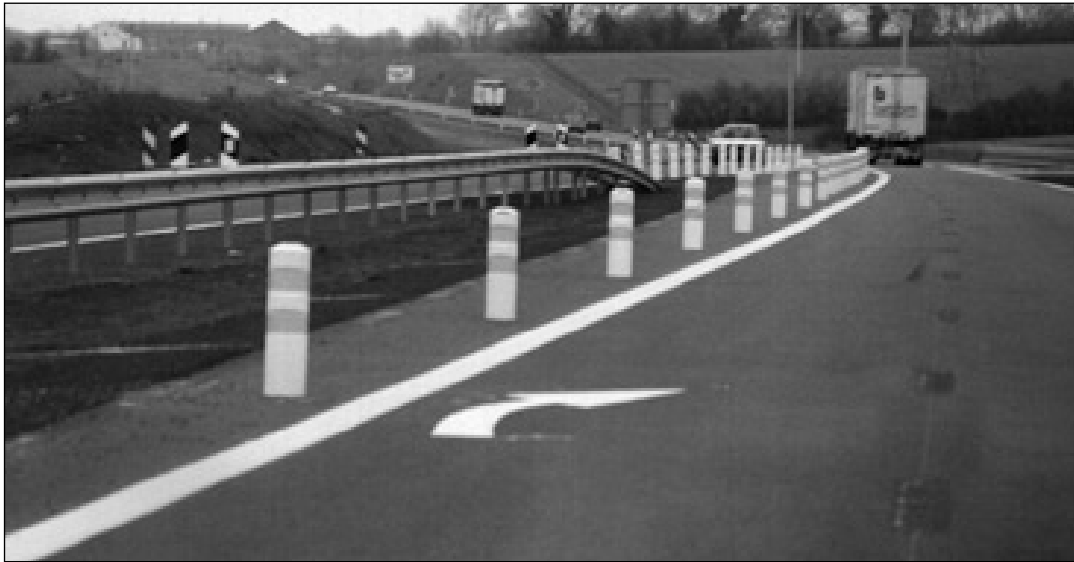
Photo 2 : Exemple d'implantation de balises souples J 11 en rétrécissement de chaussée (rabatement).
