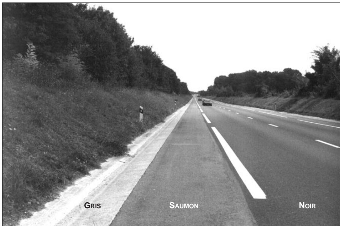
Exemple d'accotements différenciés, ici en revêtement saumon, avec une cunette en béton gris.
