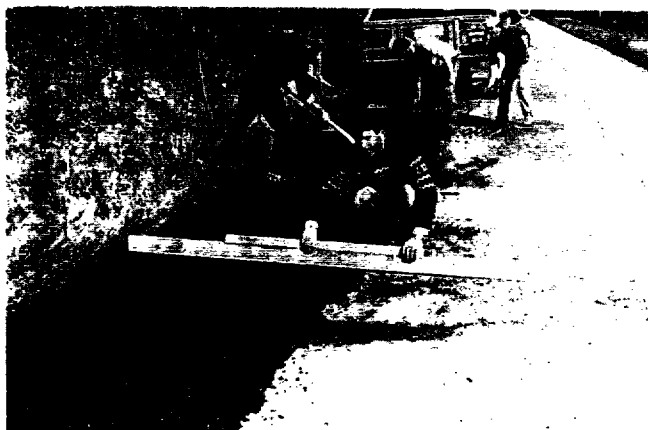
Mise en œuvre manuelle d'enrobés à chaud 0/10.
