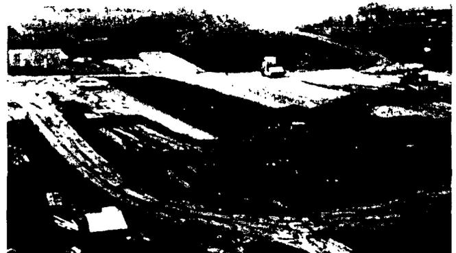
Fig. 2 : Disposition du Pneusol au-dessus d'une voûte
