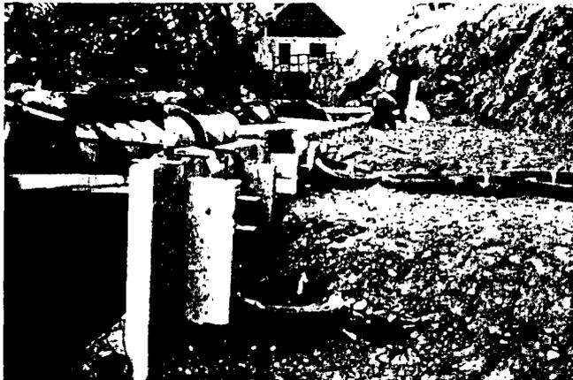
Fig. 1 : Mur Pneusol avec parement en béton
