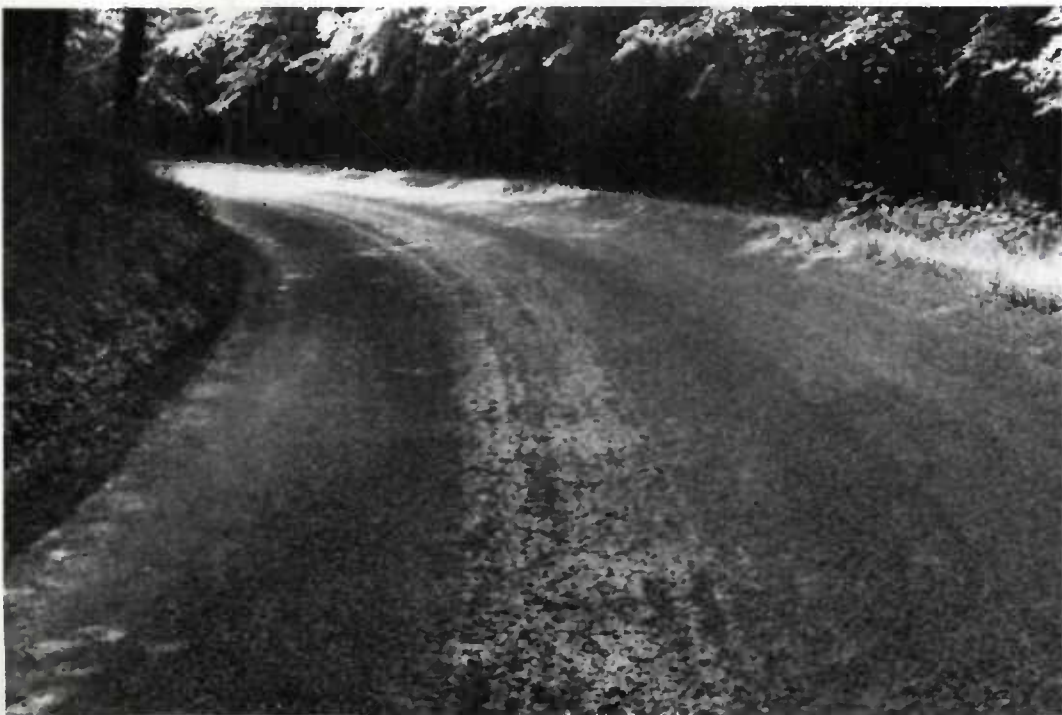
Plumage d'un enduit en sous-bois. Les granulats rejetés ne sont pas tachés par le liant (manque d'adhésivité passive). Ils forment un cordon en rive.
