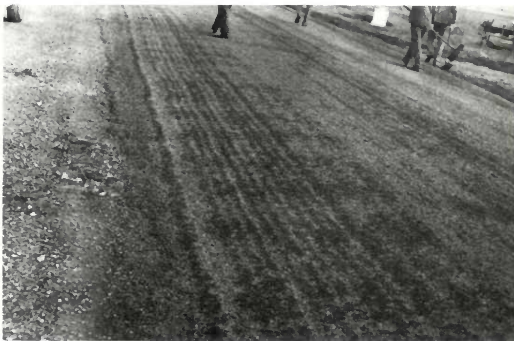
Peignage provenant d'un liant visqueux répandu à trop basse température.
