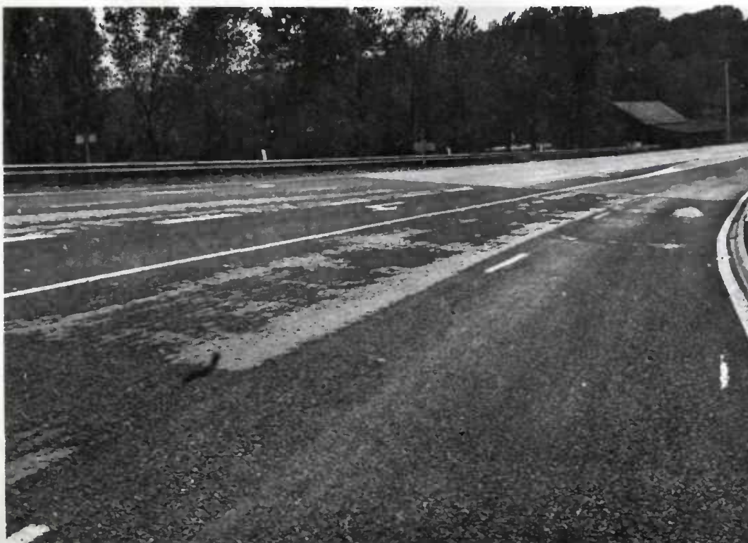
Départs de granulats causés par un sous-dosage excessif de la voie rapide (accompagné d'un peignage).
