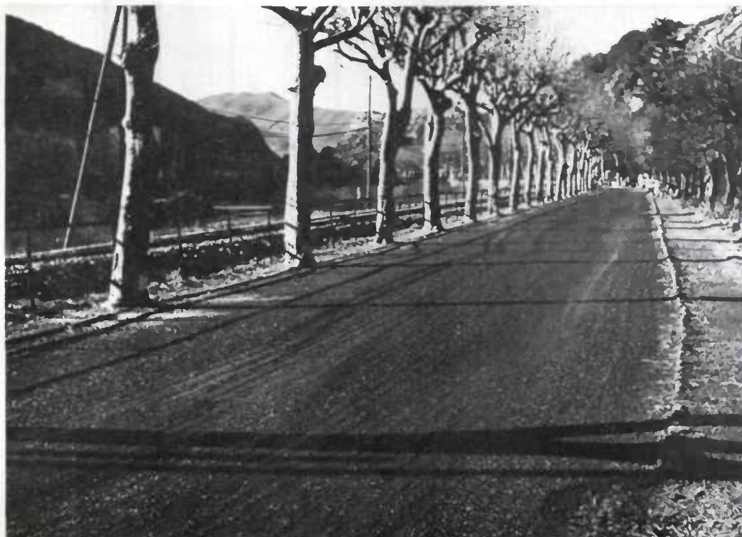
Peignage d'un enduit devant ultérieurement engendrer des ressuges.
