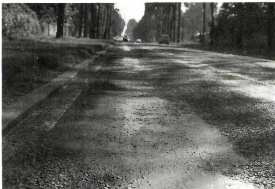
Plaques de ressuage consécutives à l'écoulement du liant dans les ornières et les flaches.
