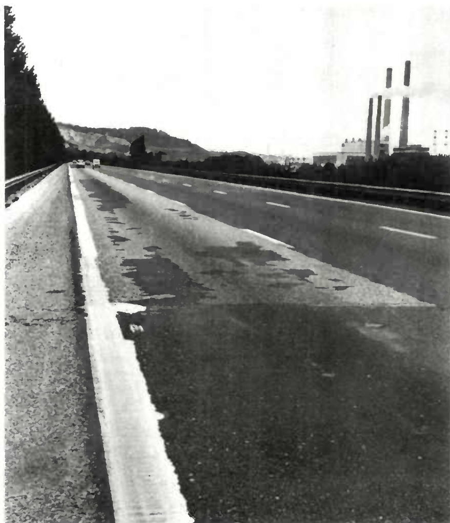
Pelades d'un enduit employant un liant thermo-durcissable (brai-époxyde) résultant d'une pollution superficielle du support qui n'a pas permis un accrochage suffisant du liant sur la chaussée.
