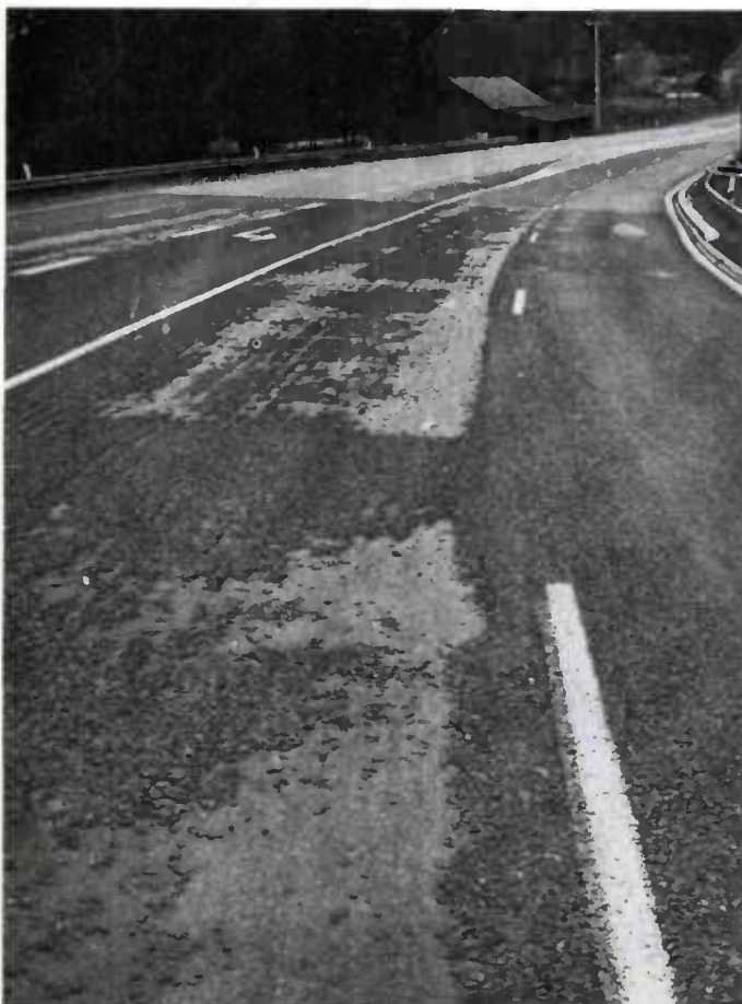
Départs de granulats causés par un sous-dosage excessif de la voie rapide (accompagné d'un peignage).
