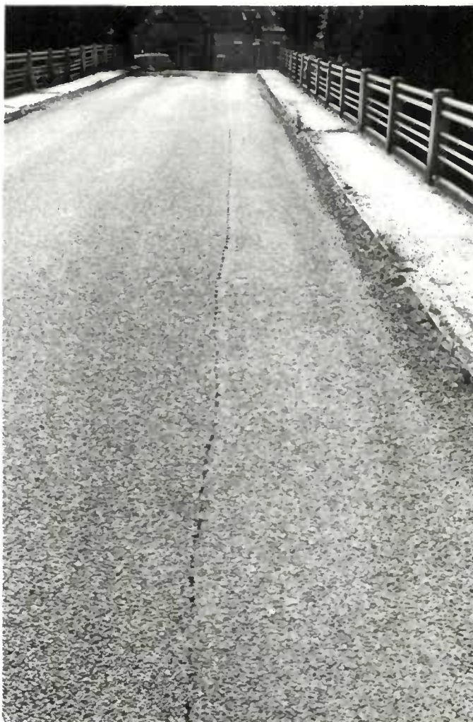
Scarification d'un enduit sur un ouvrage d'art (défaut d'imperméabilisation).
