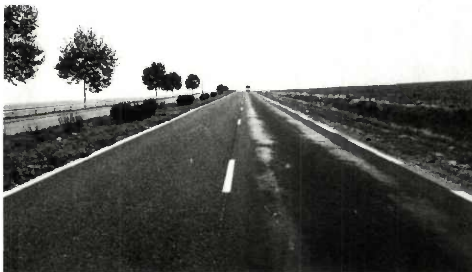
Ressuage par densification d'un bicouche dans les traces de circulation poids lourds.
