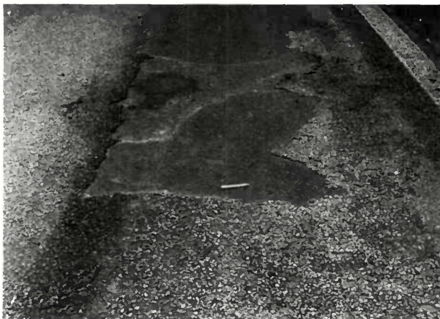
Pelades d'un enduit employant un liant thermo-durcissable (brai-époxyde) résultant d'une pollution superficielle du support qui n'a pas permis un accrochage suffisant du liant sur la chaussée.
