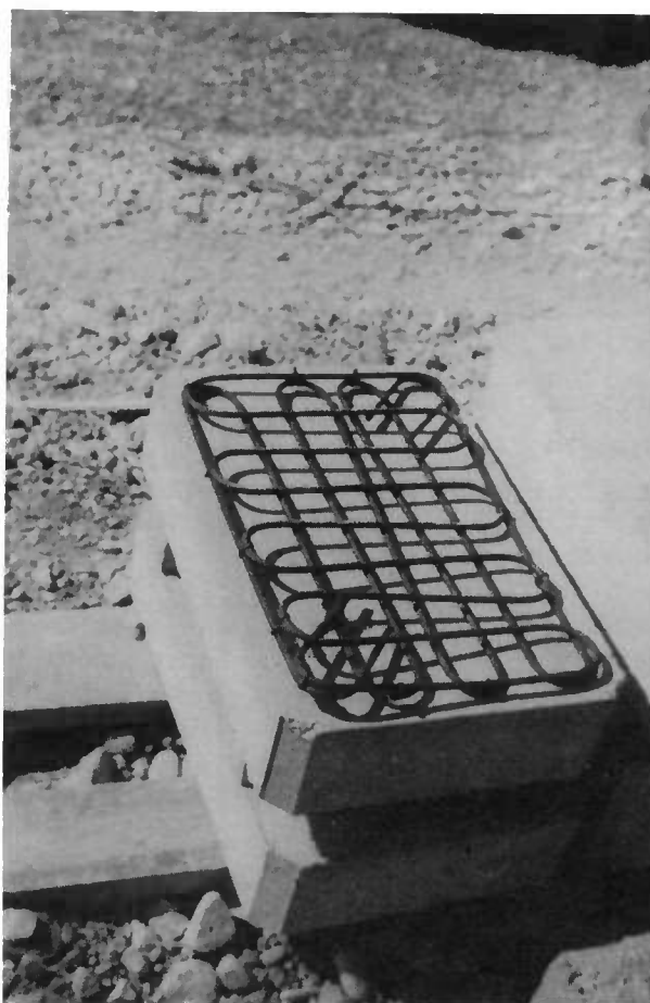
Photo 18 : Bossage préfabriqué avec son frettage
