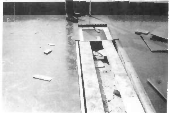
Photo n° 13 : 2 - Vue générale, un seul appareil d'appui étant posé.
