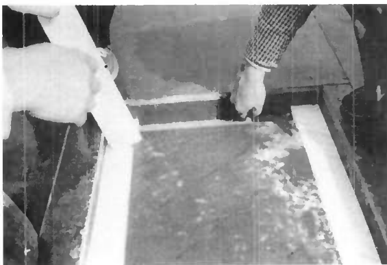
Photo n° 14 : 3 - Mise en place du polystyrène autour de l'appareil d'appui.
