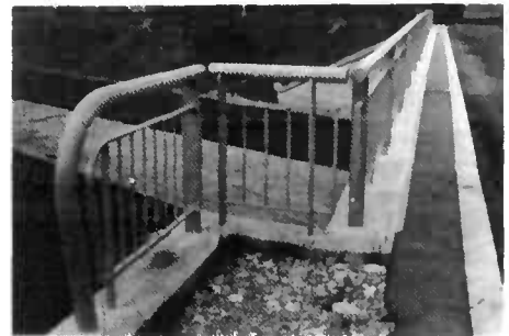
Photo b Décrochement à éviter
