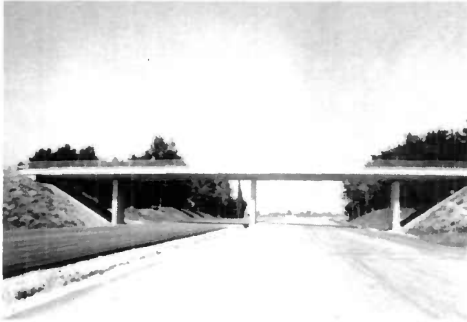
Pont-dalle à 4 travées pour plateforme autoroutière
