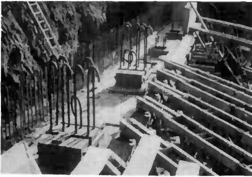
Appareil mis en place
