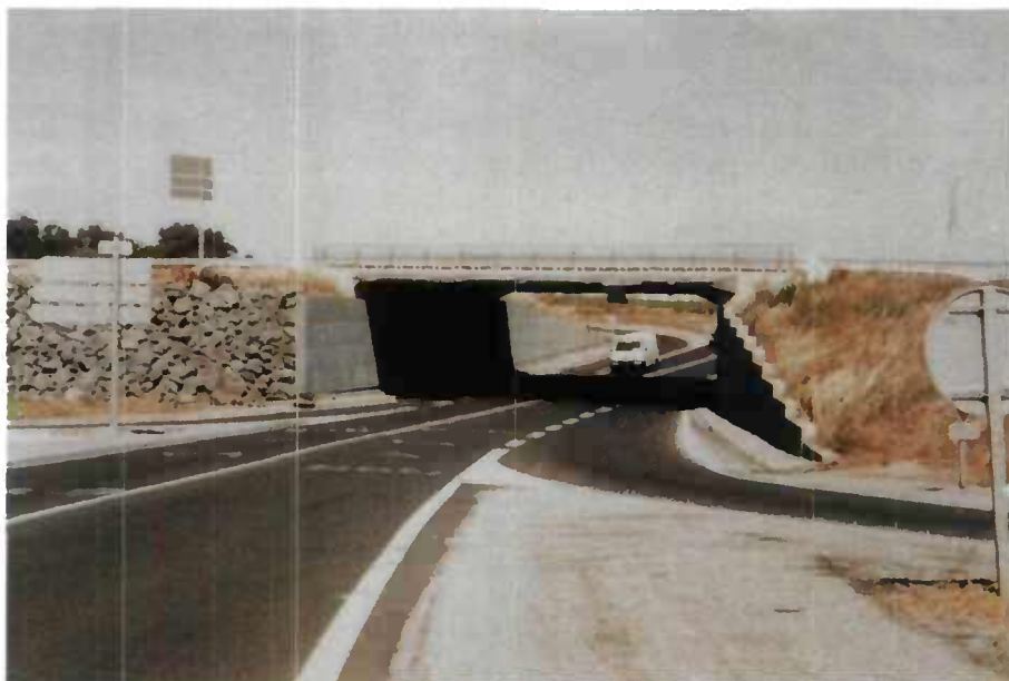
FIGURE 28 : Portique de concep- tion sobre avec une disposition originale des murs en aile
