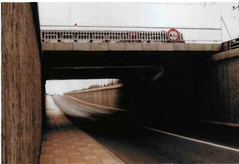
FIGURE 30 : Pont-cadre urbain encadré par des tré- mies avec parements ouvragés
