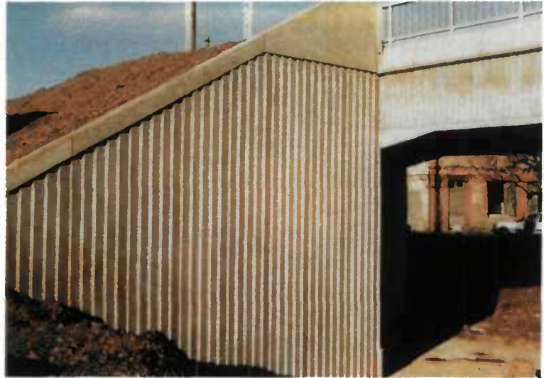
FIGURE 44 : Murs en aile préfabriqués avec parement architectural (cannelures)
