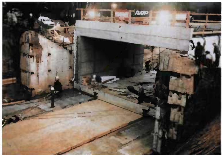
FIGURE 90 : Principe du ripage sur coussins d'air
