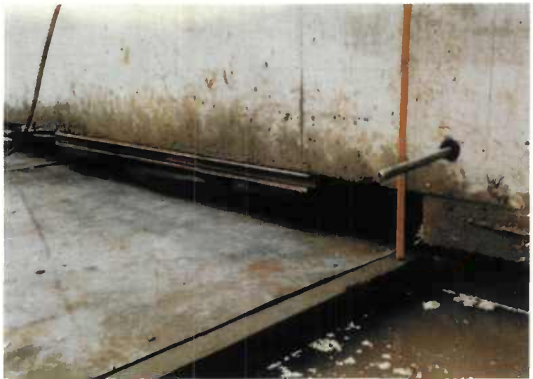
FIGURE 93 : Ouvrage sur ses coussins, prêt à être déplacé
