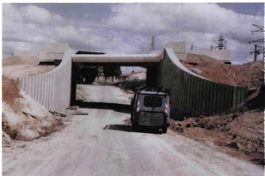
FIGURE 77 : Même disposition que la figure 76, mais avec un mur en aile courbe
