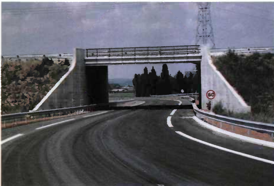
FIGURE 76 : Murs en aile sans murs en console, avec arrêt de la corniche
