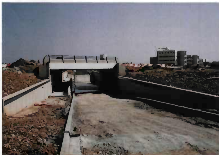
FIGURE 86 : Photo d'ouvrage avec murs préfabriqués
