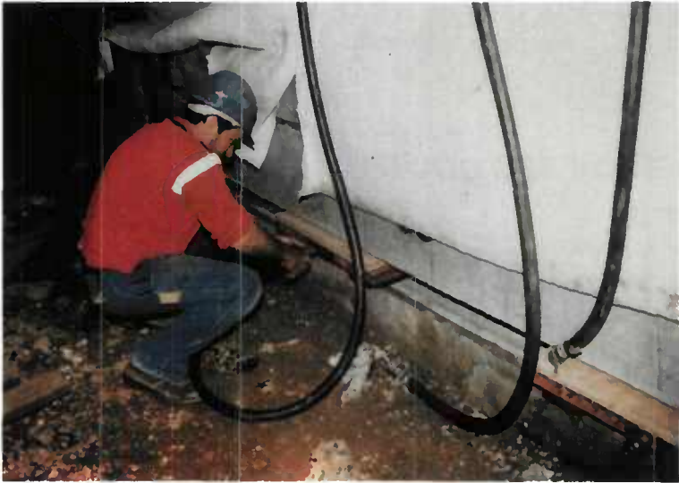
FIGURE 92 : Admission d'air dans les coussins
