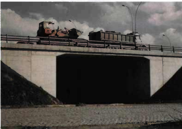
FIGURE 2 : Ouvrage avec murs en retour
