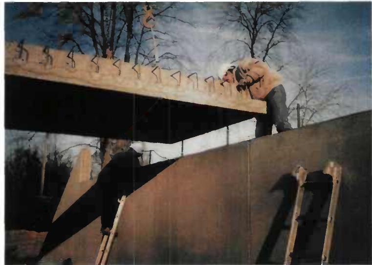
FIGURE 87 : Mise en place d'un élément de tablier préfabriqué
