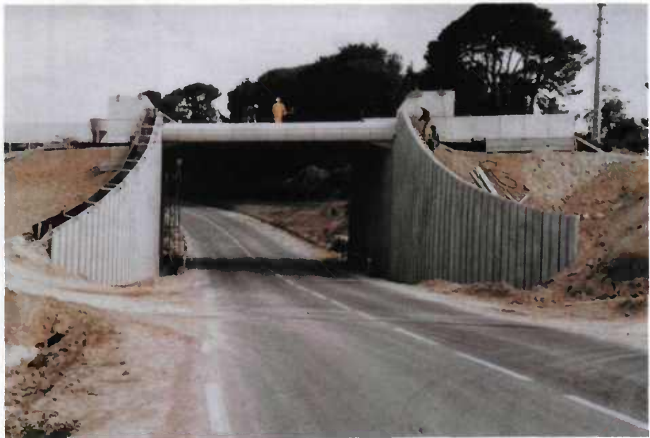
FIGURE 29 : Portique avec murs en aile courbes déli- mitant la longueur de la corniche
