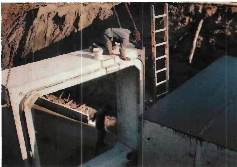
FIGURE 88 : Mise en place d'un élément de cadre préfabriqué
