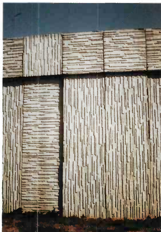
FIGURE 23 : Parements ouvragés (matrice spéciale)
