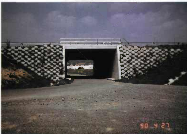
FIGURE 25 : Éléments préfabriqués stabilisateurs de talus
