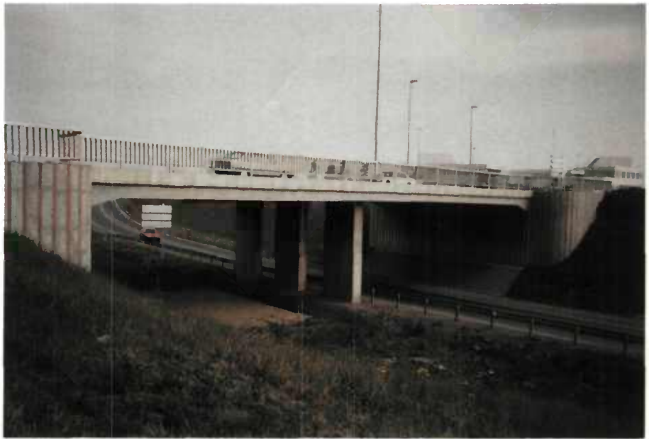
FIGURE 27 : Portique double avec murs en retour courbes
