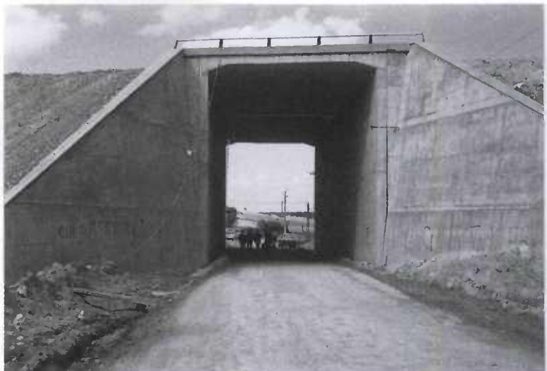
FIGURE 9 : Ouvrage inesthétique : disproportion entre l'ouverture et la hauteur, mauvaise implantation des murs de tête
