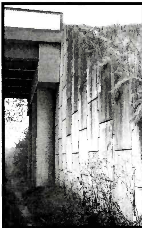
Figure B40 : Pile-culée très proche du parement terre armée
