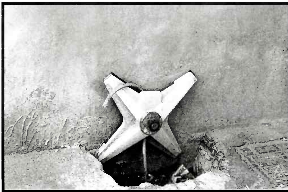
Figure B38 : clouage d'une écaille basse
