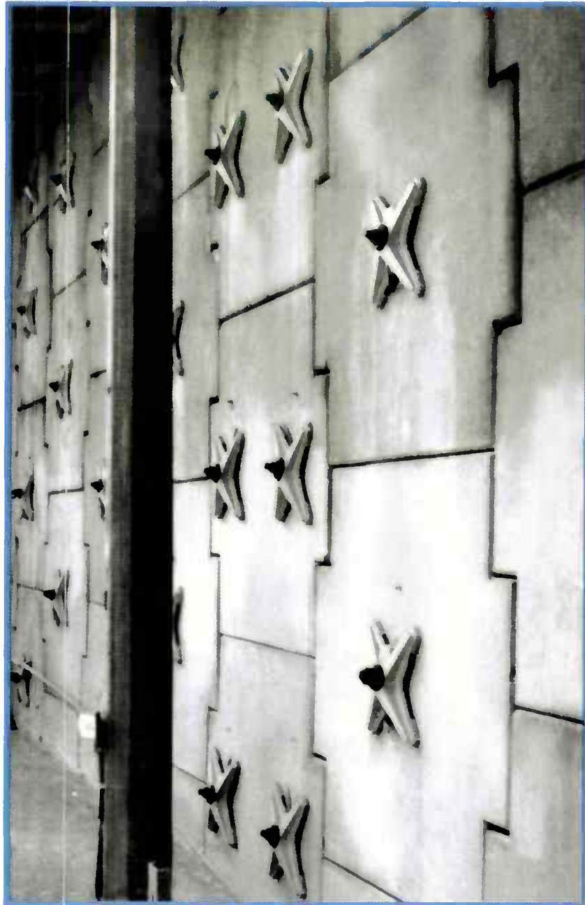
Figure B42 : clouage d'écailles par deux clous de part et d'autre d'un obstacle
