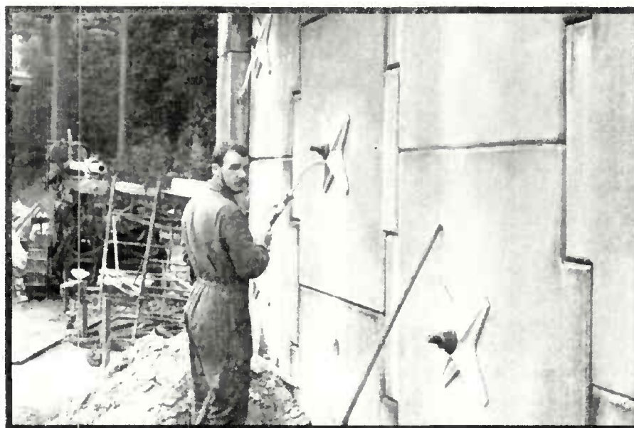
Figure B31 : Complément de coulis de scellement mis en œuvre après pose de la plaque d'appui
