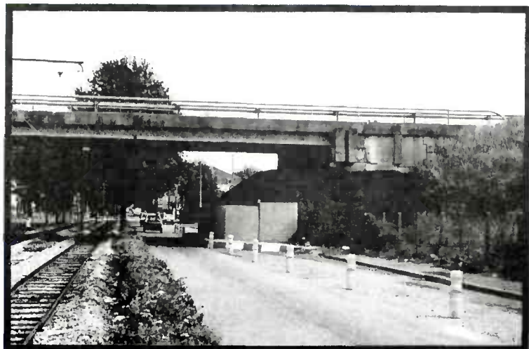
Figure B5 : Effets pouvant être induits par l'action pondérale de remblais rapportés
