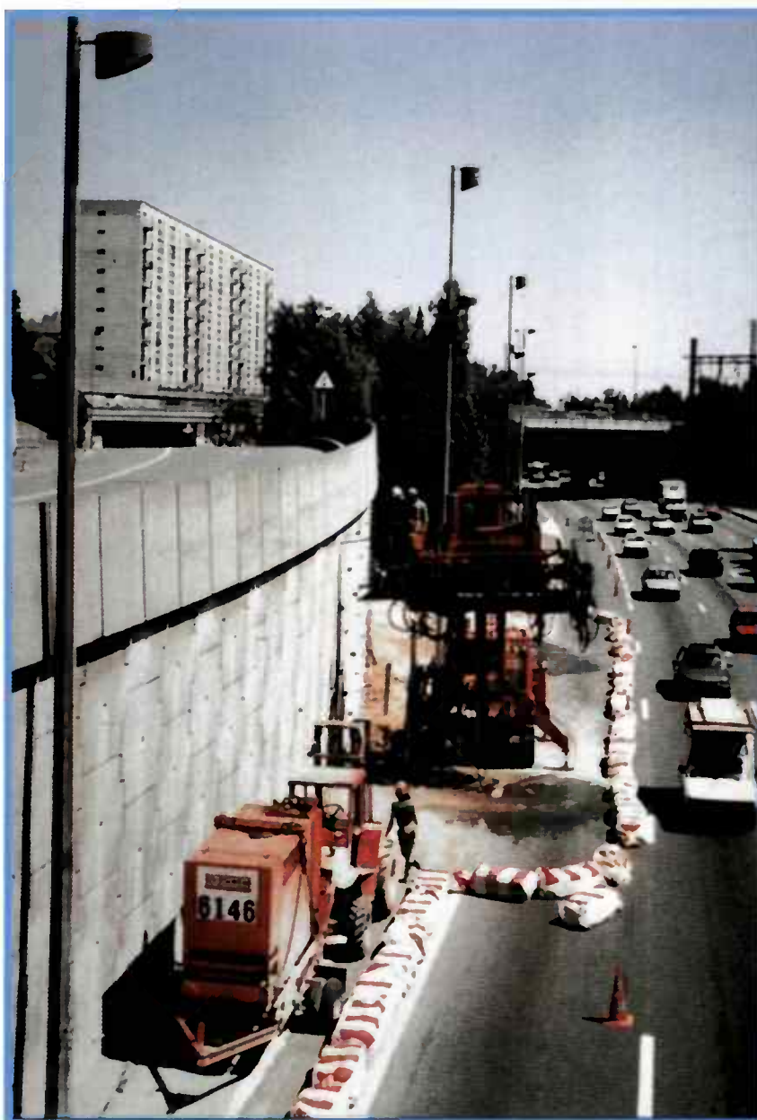
Figure B26 : Neutralisation d'une voie de circulation pendant les travaux
