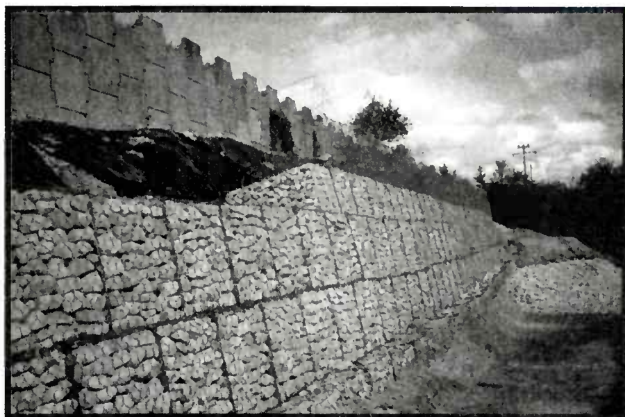
Figure B9 : Renforcement par mur en gabions
