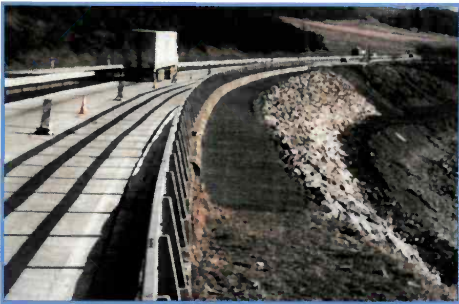
b - situation après confortement (remblai avec risberme)
