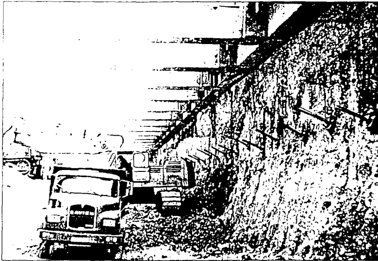
Figure 1 : Tranchée ouverte en parois moulées en site fortement urbanisé
