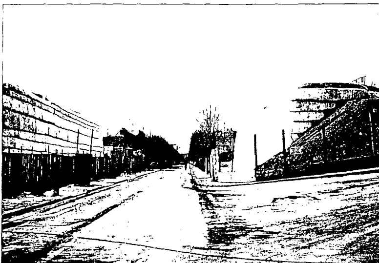
Figure 9 : Remblai de préchargement renforcé par nappes de géotextiles (ouvrage provisoire)
