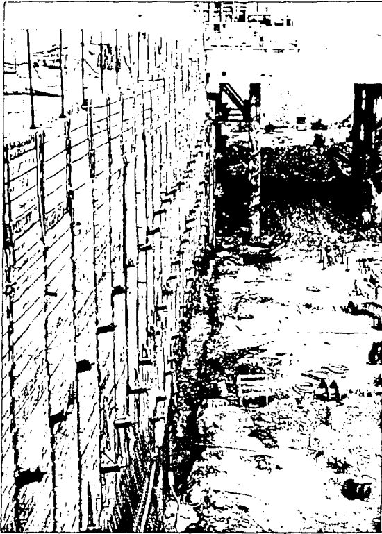
Figure 8 : Ouvrage de soutènement provisoire sensible (paroi berlinoise de forte hauteur en site urbain)
