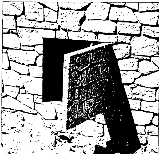
Figure 13 : Trappe de visite dans un parement rapporté (accès à un parement géotextile)
