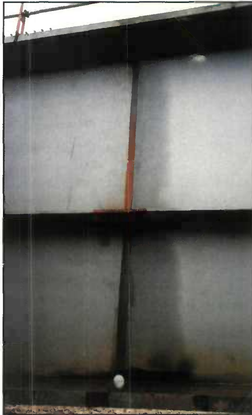
Photo 1 : Raboutage de deux tronçons de poutre avec découpe en "trou de souris" dans l'âme.
