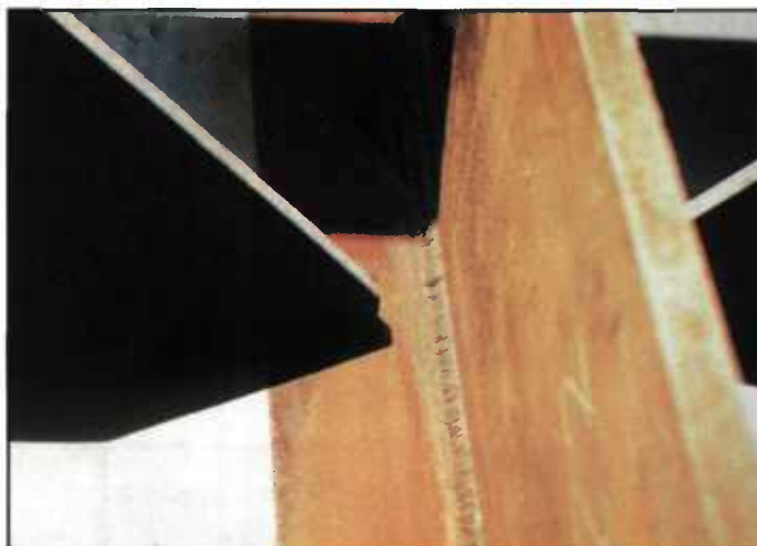
Photo 12 : Extrémité de raidisseur longitudinal arrêtée trop brutalement : "nez" trop large, pente trop forte.
