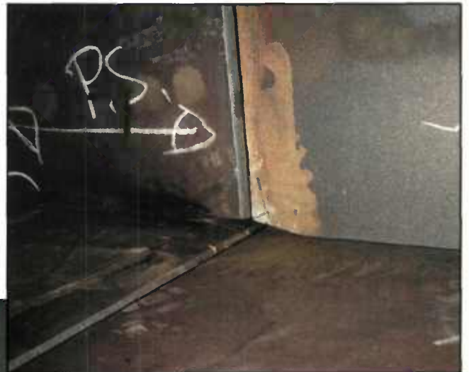
Photo 2 : Raboutage avec découpe en "ailes de mouette" (avant soudage).
