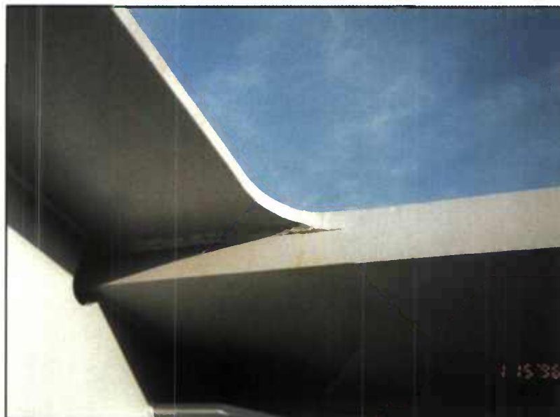
Photo 5 : Assemblage avec gousset circulaire.
