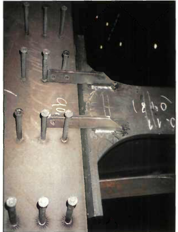
Photo 6 : Préparation d'un assemblage avec gousset circulaire.
