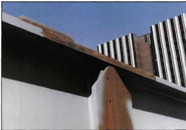
Photo 7 : Extrémité de raidisseur d'âme en Té.
