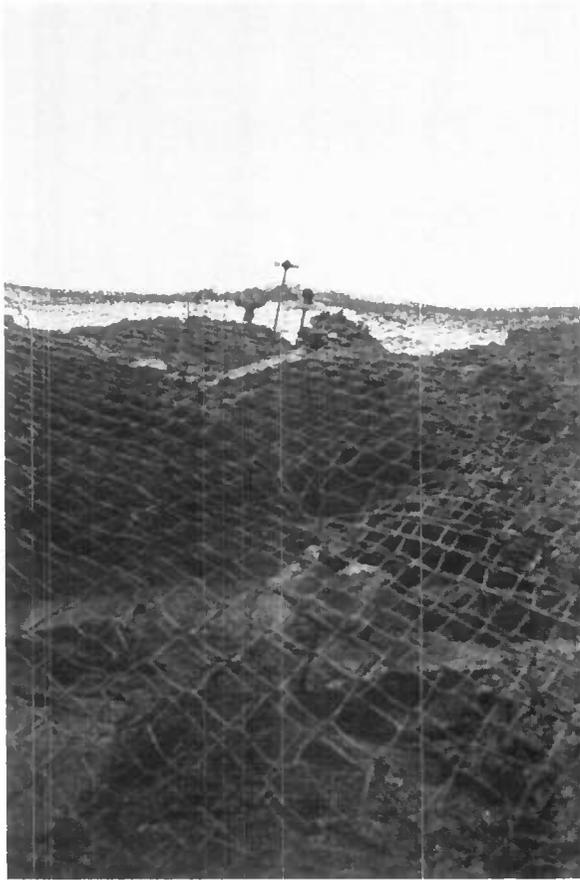
Fig. 9 - Détérioration des ancrages de la couverture grillagée d'un talus.
