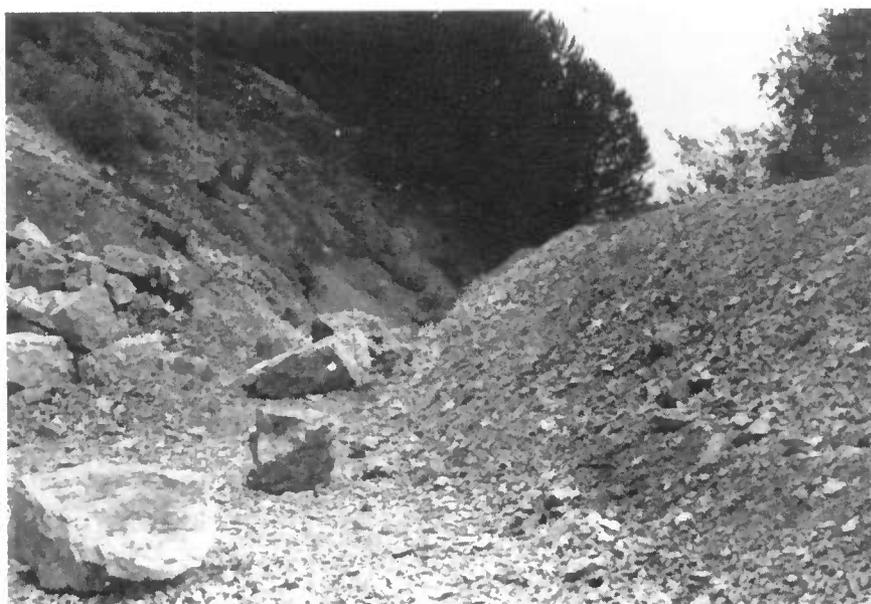
Fig. 6 - Arrêt des blocs dans le piège à cailloux.
