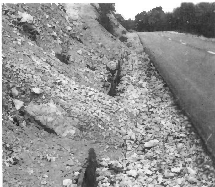
Fig. 7 - Piège à cailloux de capacité insuffisante.
