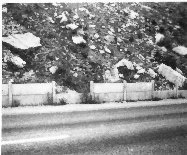
Fig. 8 - Écran non adapté à la taille des blocs.
