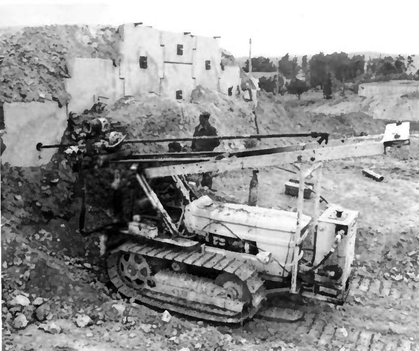
Fig. 10 — Forage pour la mise en place de tirants passifs pour remplacer des armatures corrodées.
