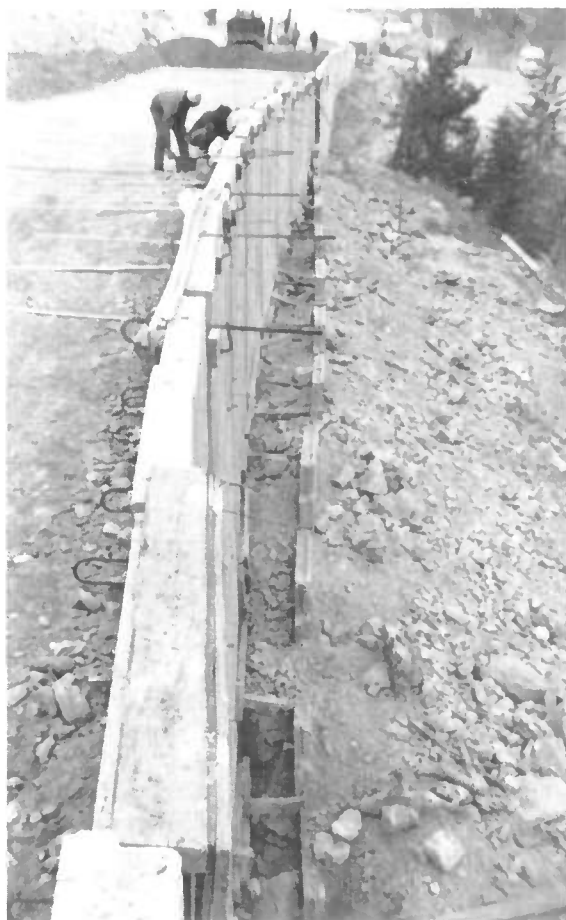
Fig. 11 Démontage et remontage d'un mur à parement béton.
