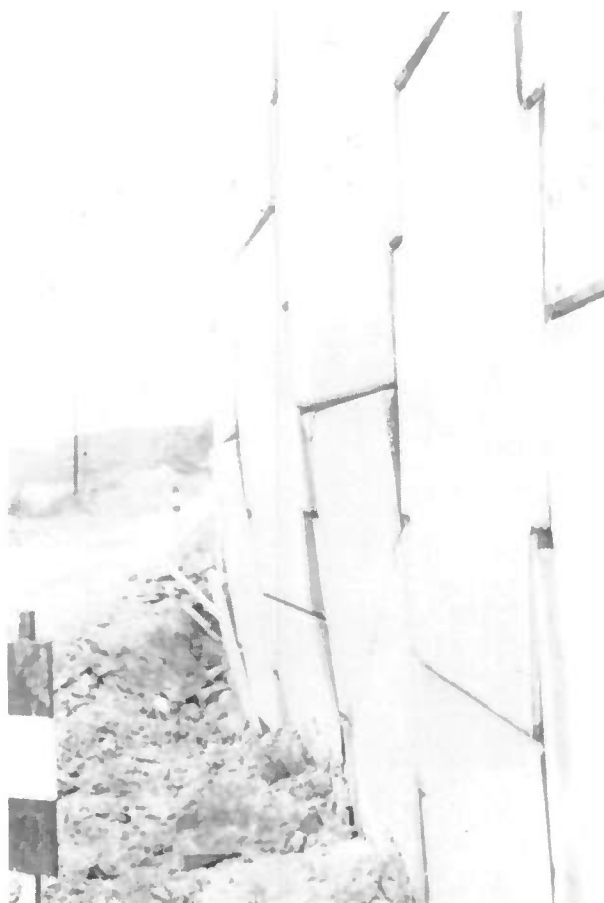
Fig. 6 — Parement ayant subi un renflement.
