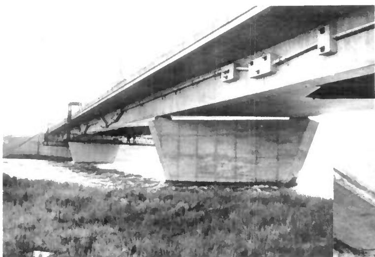
b — Câbles ancrés dans des bossages rapportés en béton armé et déviés par des déviateurs en béton armé.
