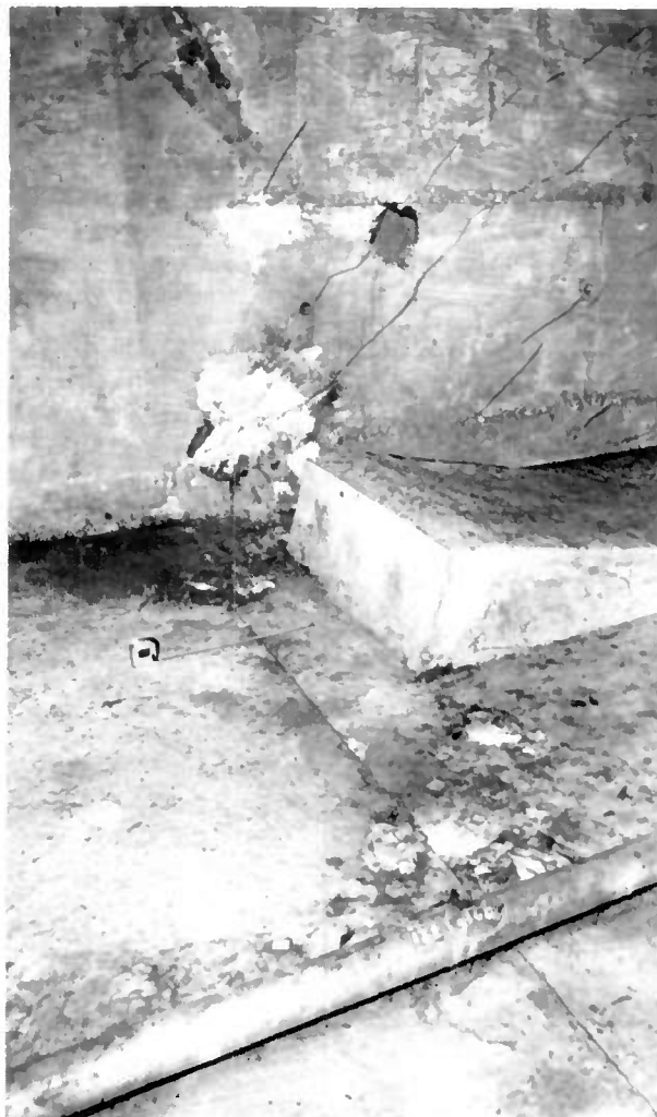
Fig. 29 — Exemple de propagation de fissures d'entraînement et de diffusion.
