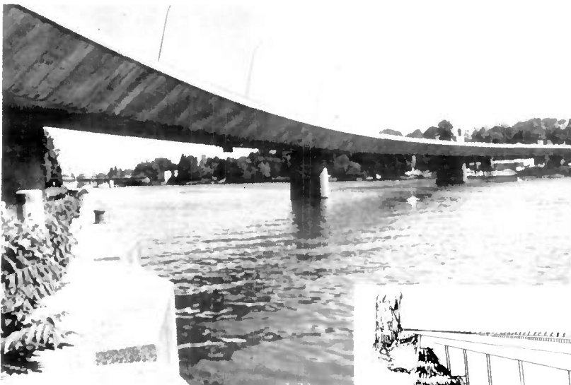
Fig. 2 — Poutre continue de hauteur constante.
