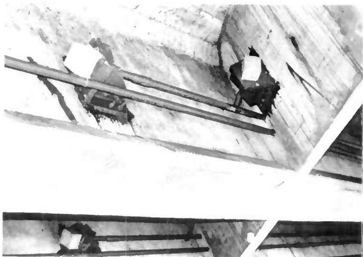
a — Câbles ancrés dans des bossages métalliques.
