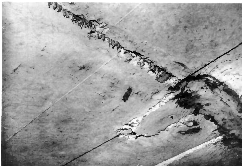
Fig. 58 — Exemple de mauvaise conjugaison des joints.
