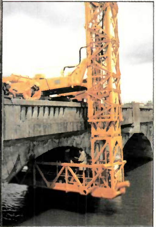
Passerelle de visite
