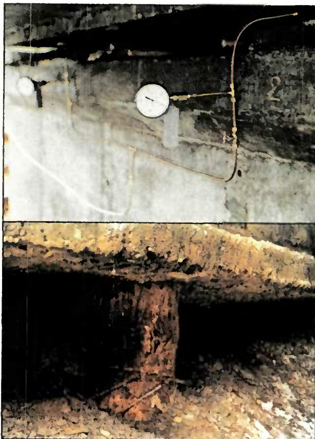
Affouillement de fondation avec exposition à l'air de pieux en bois
