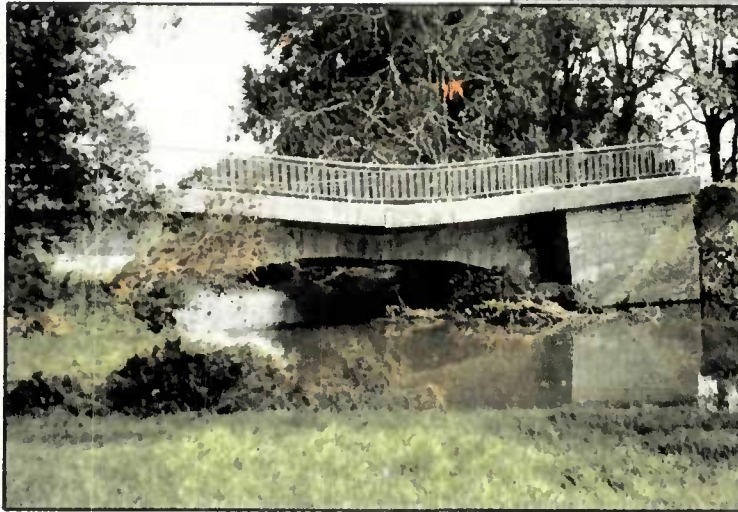
Contournement d'une culée et ses conséquences
