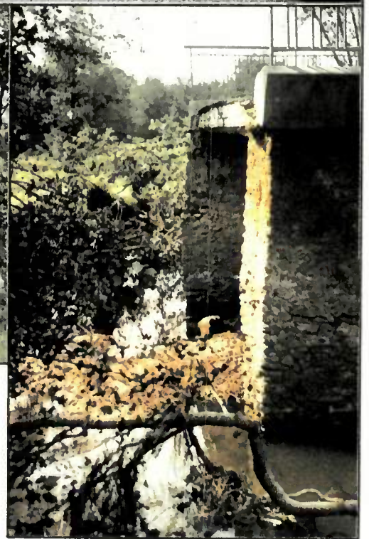
Contournement d'une culée et ses conséquences
