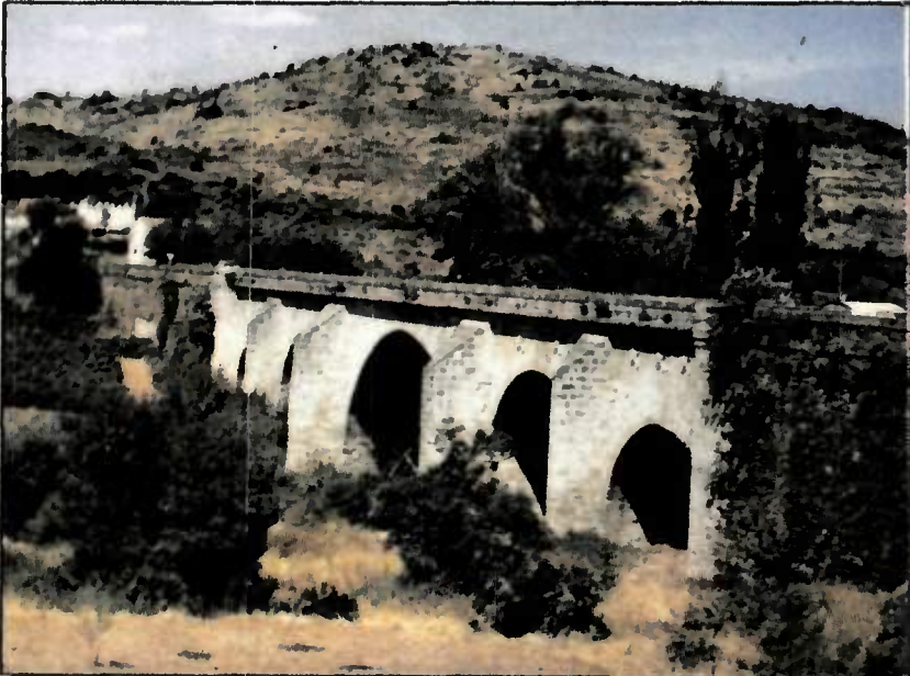
Pont en maçonnerie et mur de soutènement en pierres sèches
