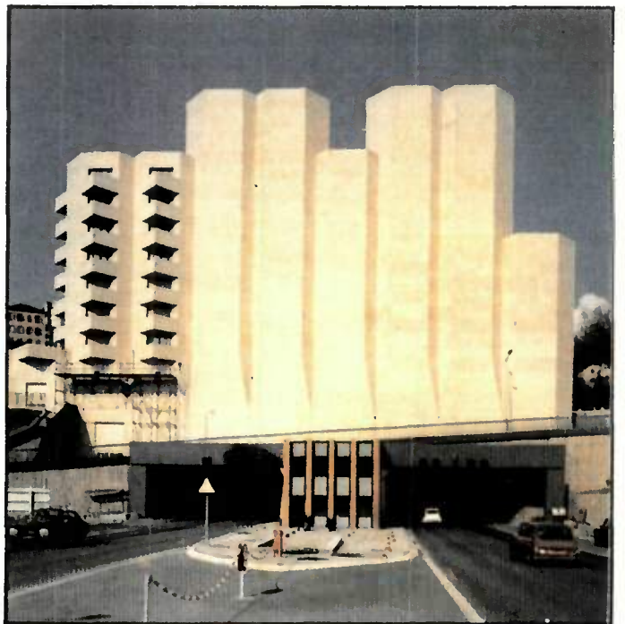
Entrée du tunnel de Fourvière
